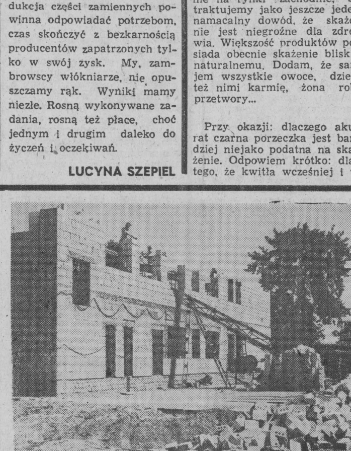
Mury nowego sklepu rosną w oczach.
