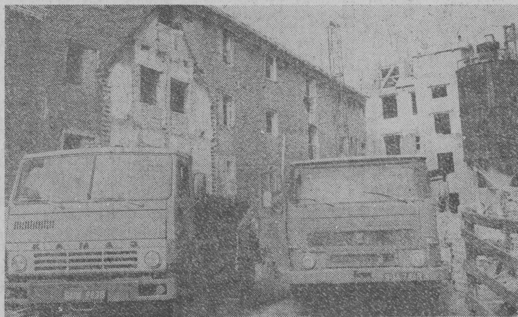
Gruntowny remont budynków przy ul. Dzierżyńskiego 26/28 w Elku potrwa do lipca przyszłego roku.
