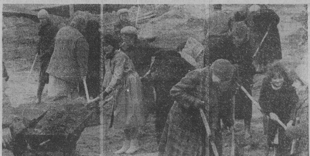
Pracownicy OW CZSS „Społem” w Łomży pracowali przy porządkowaniu terenu przy magazynach.
