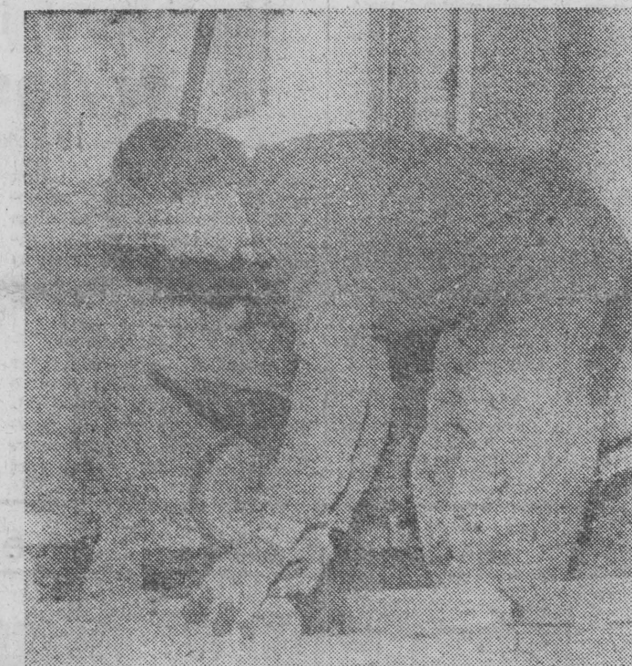
Stanisław Cimoch wykonuje prace murarskie.
