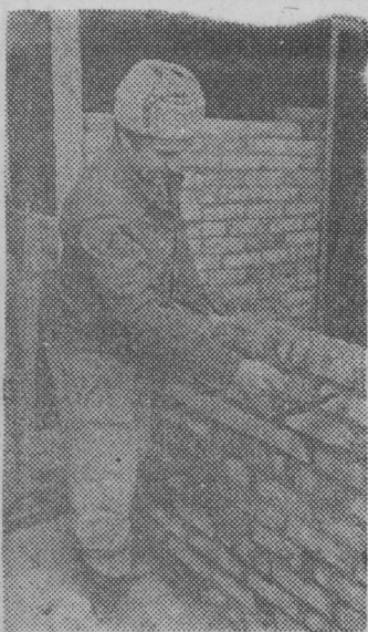
Edward Turczewski muruje ścianki działowe.
