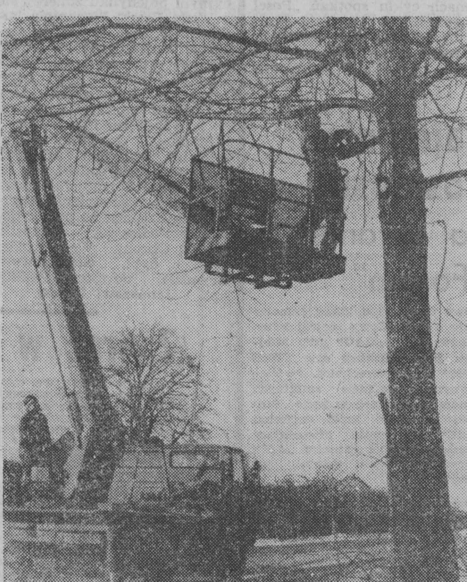
Taka kosmetyka przydrożnych drzew jest konieczna aby drogi, przy których rosną, były bezpieczniejsze. CAF — STASZYSZYN
