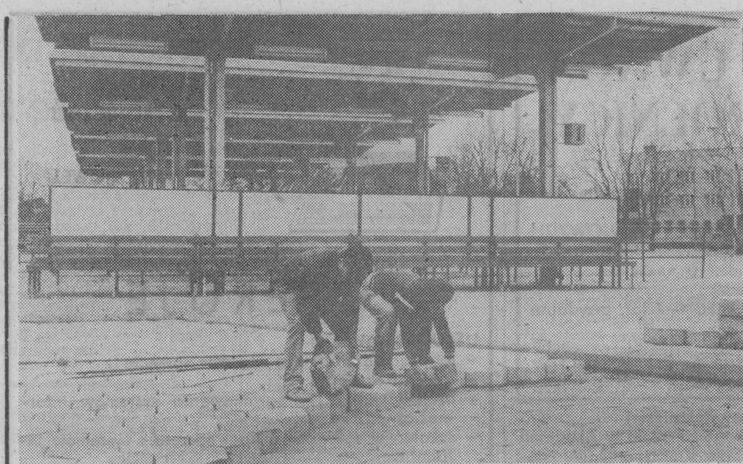
Nasz fotoreporter uwiecznił ostatni moment układania trylinki na placu manewrowym
