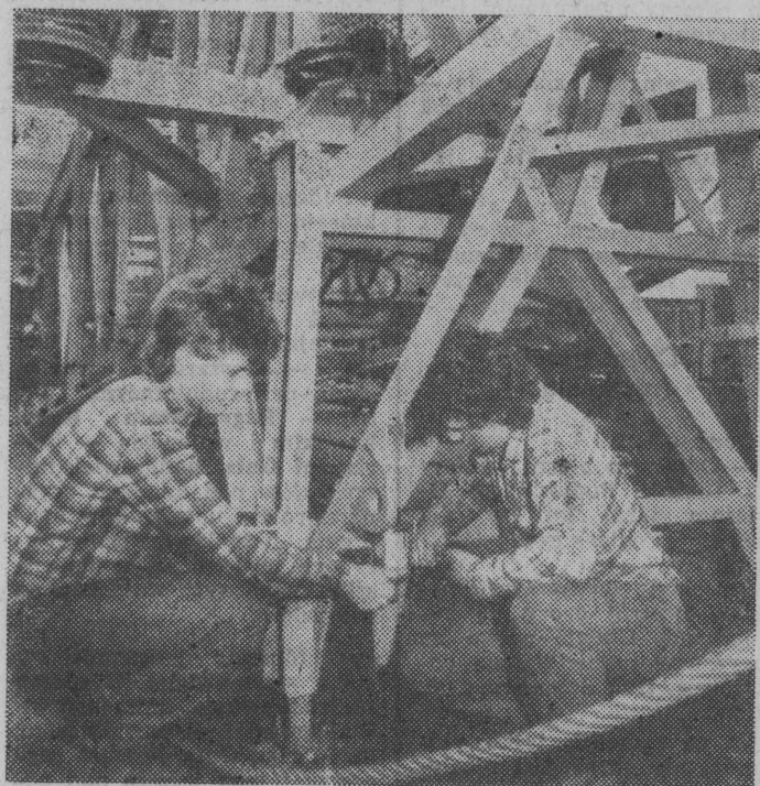
Elektrycy Piotr Kryś i Marek Waleśki naprawiają instalację żurawia.
