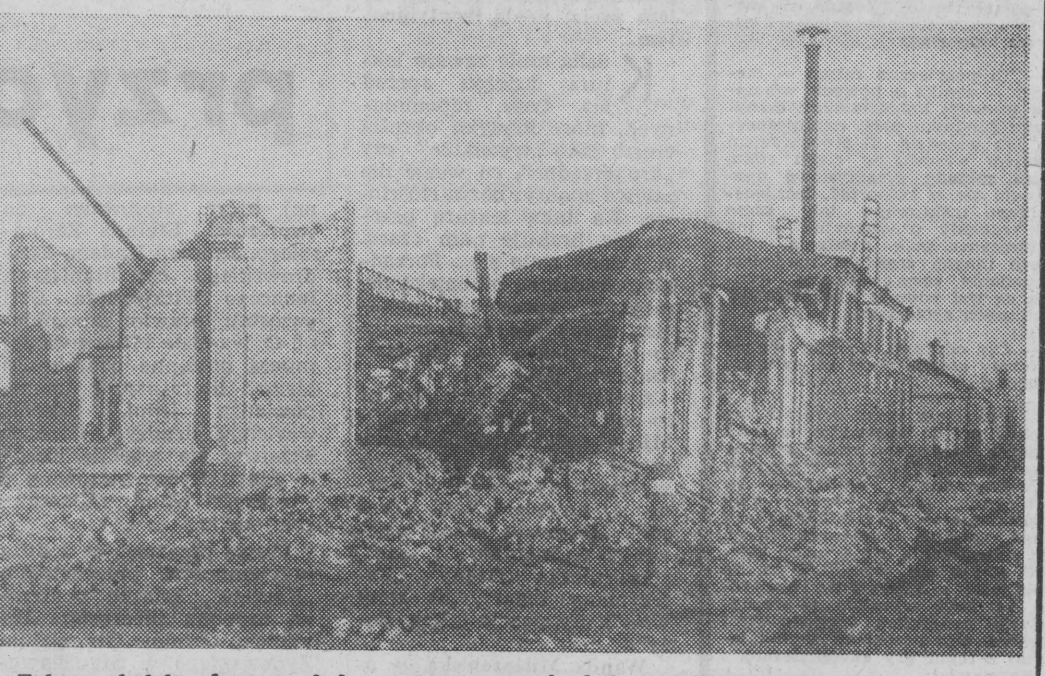
Tak wyglądała zburzona hala napraw zestawów kołowych ZNTK w Łapach.
