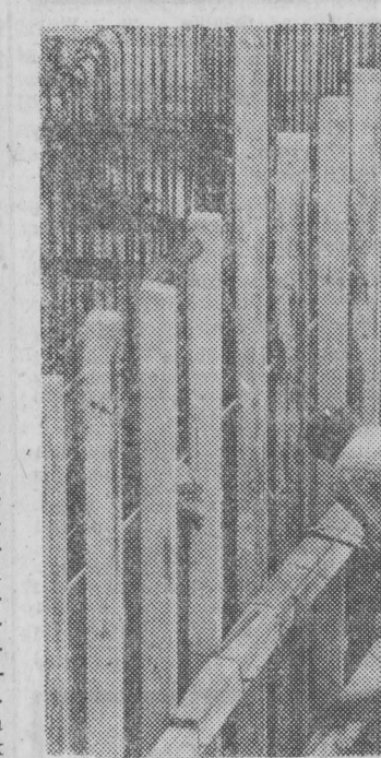
Prace przy budowie oczyszczalni ścieków w Białymstoku.
