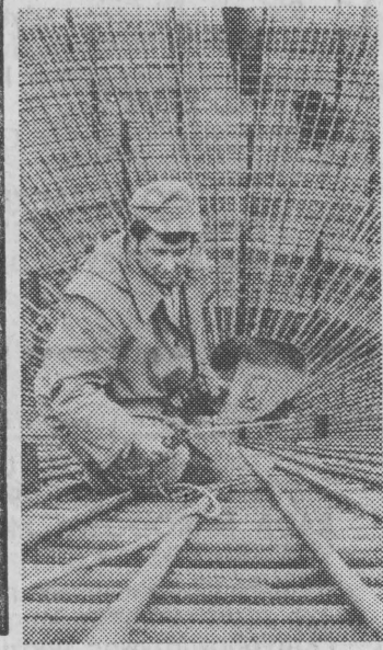
Prace przy budowie oczyszczalni ścieków w Białymstoku.
