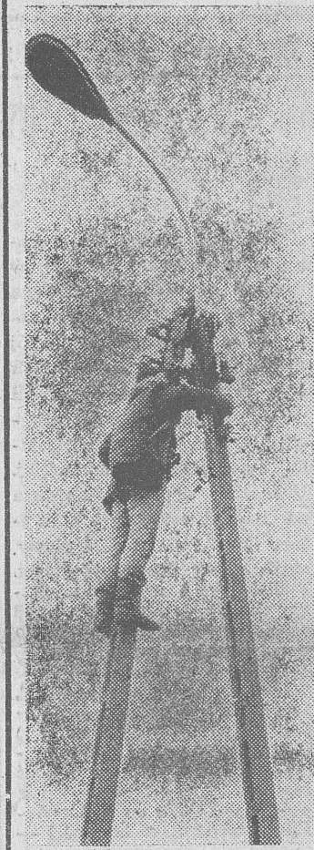
Monter TOMASZ KUCH- LEWSKI zakłada uzemnienie na słupie uszkodzonej linii średniego napięcia w Staro- sielech. Naprawienie zerwa- nych tam przewodów trwało wczoraj do wieczora. Fot. ZDZISŁAW ZAREMBA
