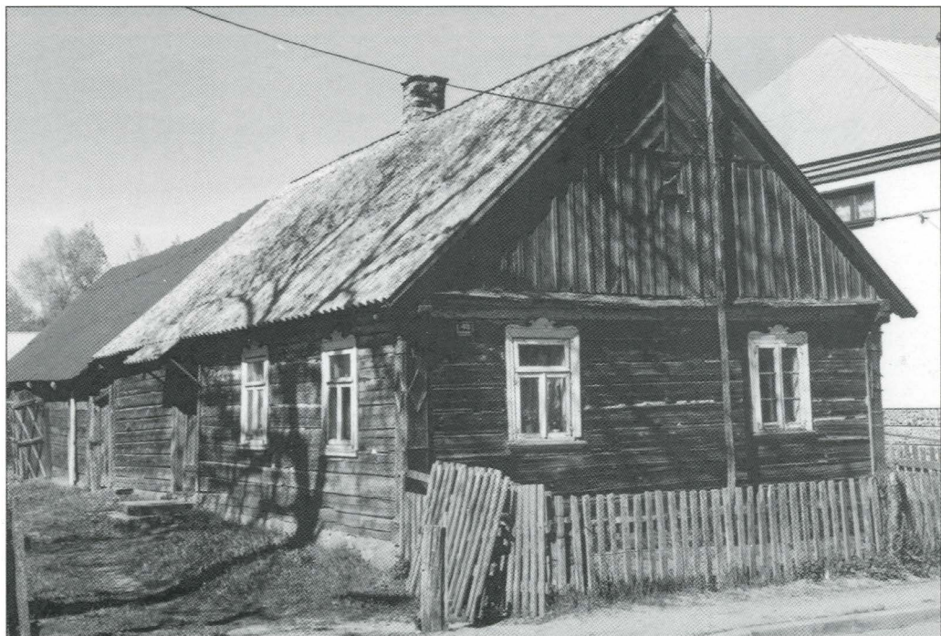
Zabiele. Dom mieszkalny drewniany nr 45. (6.05.2003)
