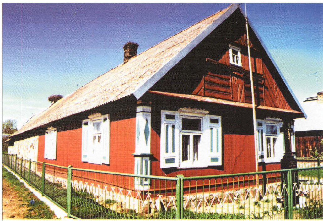
Zabiele. Dom mieszkalny. Rok budowy 1924. (6.05.2003)
