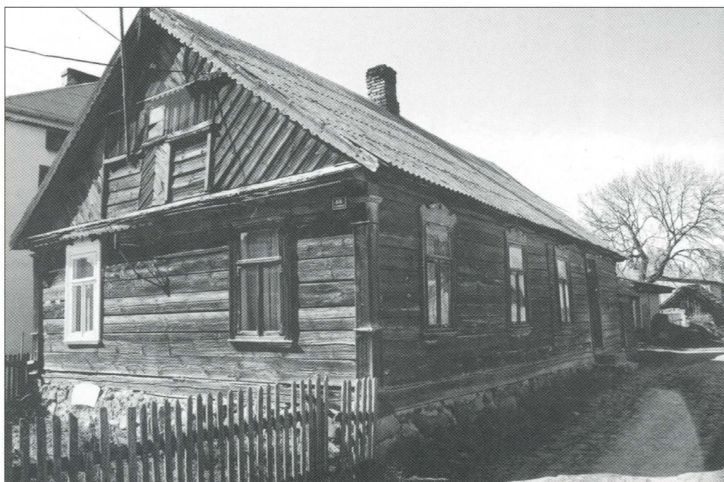
Zabiele. Dom mieszkalny drewniany nr 88. (6.05.2003)
