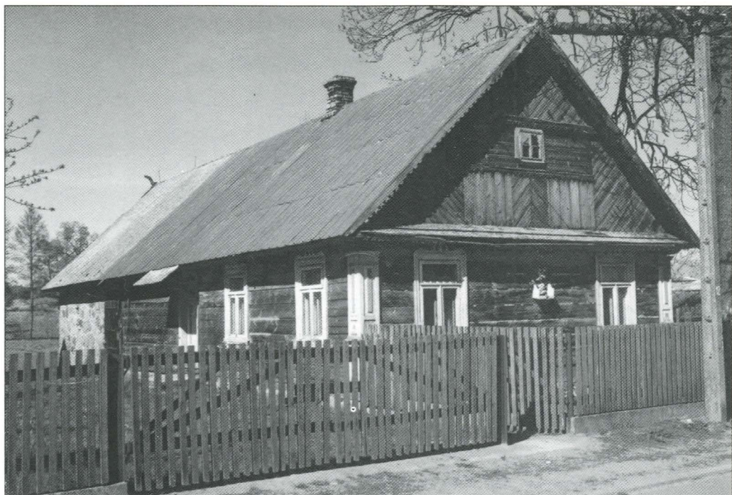
Zabiele. Dom mieszkalny drewniany nr 19. (6.05.2003)
