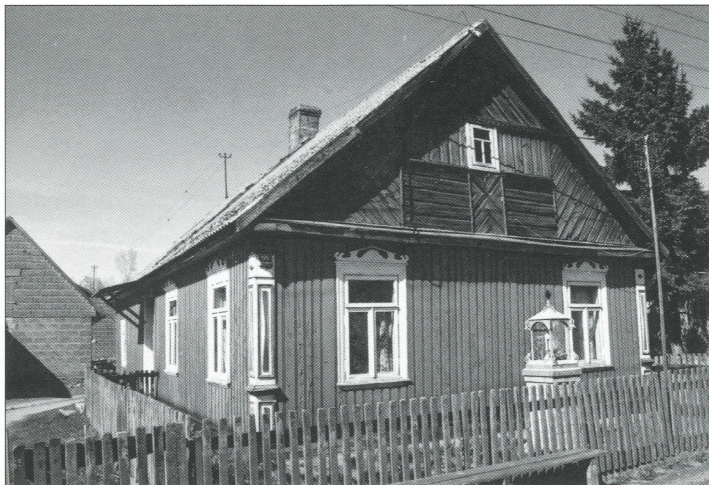
Zabiele. Dom mieszkalny drewniany nr 55. (6.05.2003)
