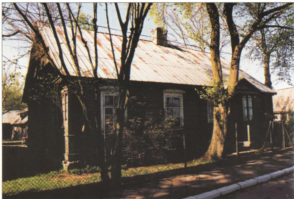
Dolistowo Stare. Dom mieszkalny nr 12. Rok budowy 1919. (6.05.2003)
