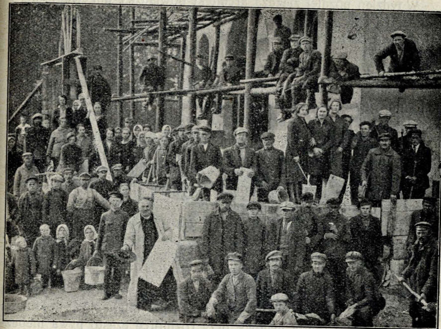
Parafianie Waranowiccy wylewają z żelazo-betonu mury kościoła.
