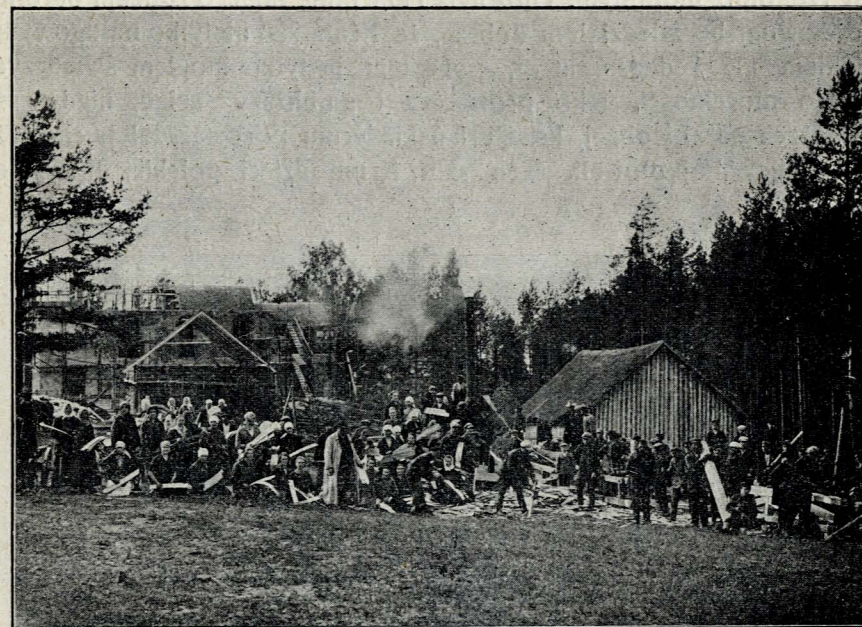
Tartak dla zagatawiania desek etc. przy budowie kościoła w Waranowiczach.
