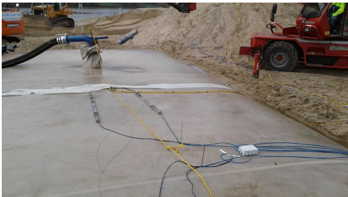
Rys. 6. Napętnianie georury. Widoczne czujniki pomiarowe zamontowane na płaszczu (fot. B. Smoliński)
