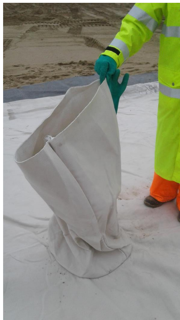
Rys. 2. Kominiek do napełniania georury (fot. B. Smoliński)
