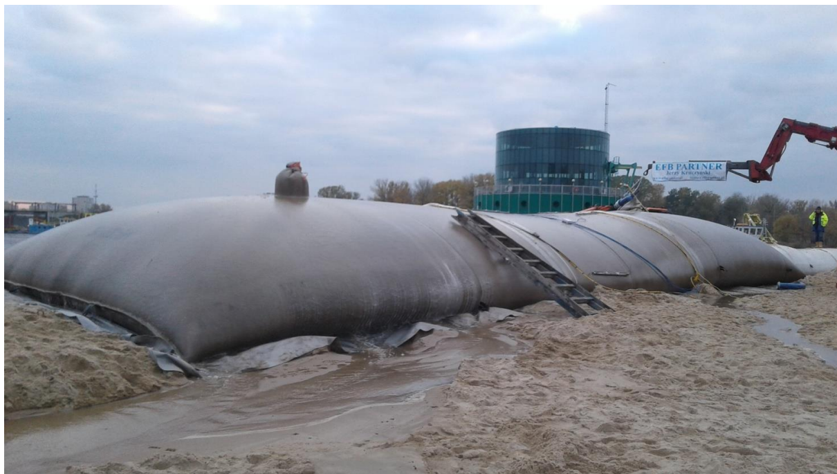
Rys. 5. Napętniona georura (fot. B. Smoliński)
