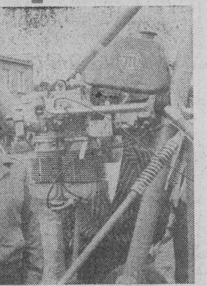
„Będąc dwa lata temu w okolicy Augustowa — wspomniał Jan Bondaruk z Białegostoku — zobaczyłem hobbystów z Wrocławia latających na motolotni. Wówczas postanowiłem również coś takiego zbudować. Większość prac wykonalem sam i przy pomocy kolegów w moim dwupokojowym mieszkaniu.” Motolotnia napędzana jest silnikiem od „Trabanta” odpowiednio „odchudzoną”, aby zmniejszyć ciężar. Wczoraj po raz pierwszy konstruktor zaprezentował to lotnicze urządzenie na lotnisku Aeroklubu. Wymaga ono jeszcze drobnych ale bardzo istotnych prac, aby mogło odbyć pierwszy lot. Gazeta na pierwszy pokaz lotu motolotni Jana Bondaruka była zaproszona. Fot. ZDZISŁAW LENKIEWICZ
