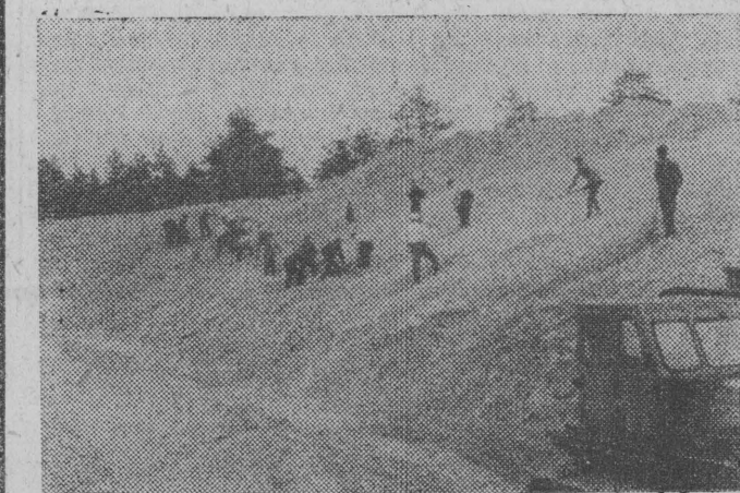
Tysiące metrów sześciennych ziemi trzeba było wywieźć lub przesunąć, aby uformować nieckę stadionu. Większość robót ziemnych wykonana była w czynie społecznym.
