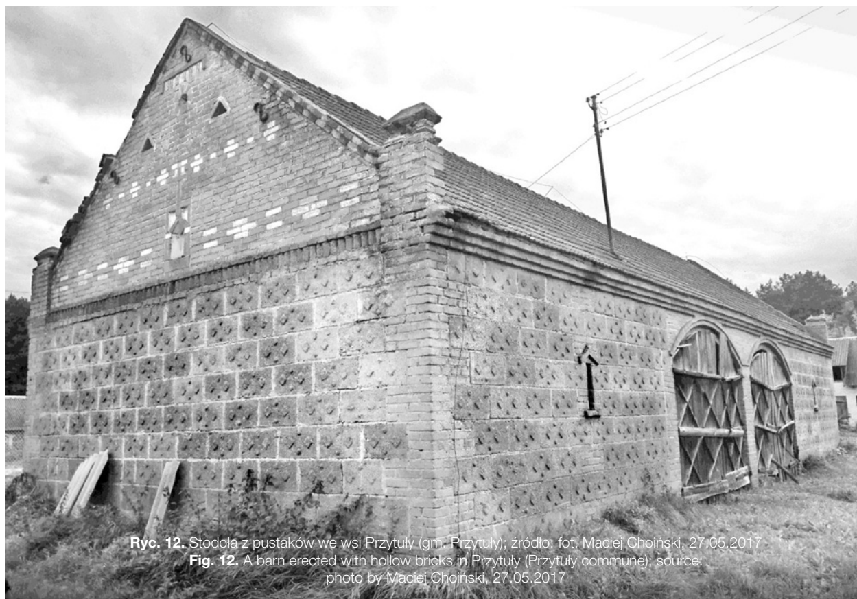
Ryc. 11. Stodola z pustaków we wsi Przytuly (gm. Przytuly); źródło: fot. Maciej Chojński, 27.05.2017 Fig. 11. A barn erected with hollow bricks in Przytuly (Przytuly commune); source: photo by Maciej Chojński, 27.05.2017
