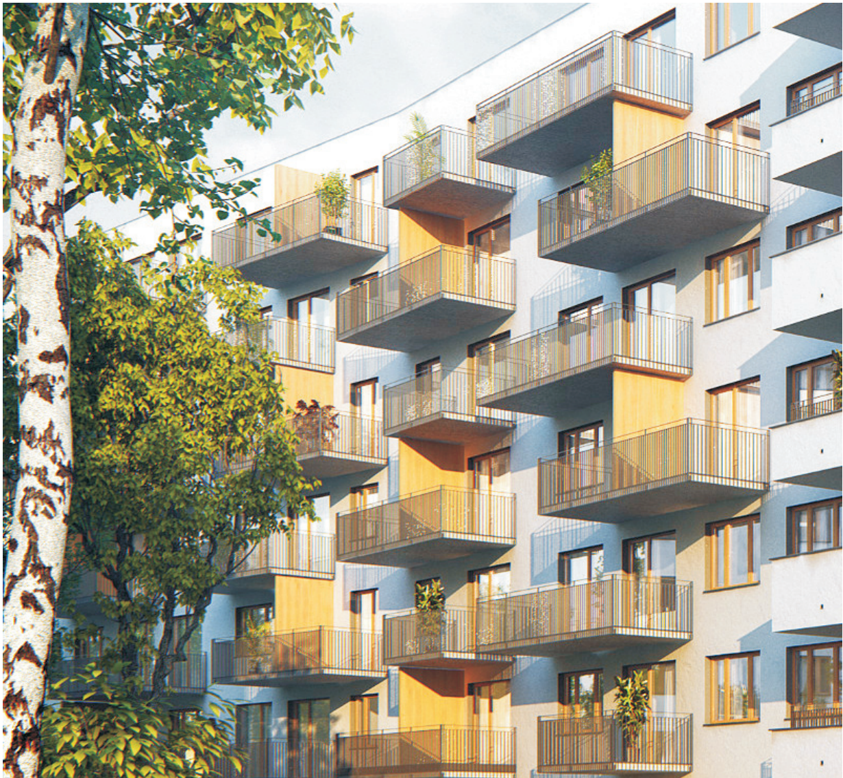
Ryc. 7. Widok osiedla Mickiewicza w Warszawie; źródło: Skanska Residential Development Poland Sp. z o.o. http://mieszkaj.skanska.pl/mickiewicza [dostęp: 06.2017]
