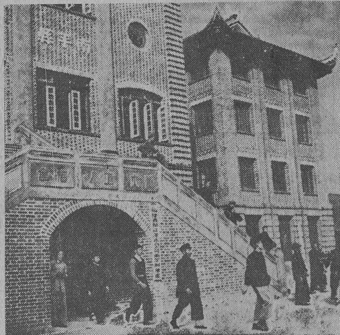
W okresie władzy ludowej wybudowano w Chinach liczne osiedla, domy i hotele robotnicze. Na zdjęciu: Fragment domu robotniczego w okręgu Nang-ping. (Fot — CAF)
