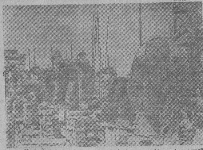
Na tej budowie chłopcy nauczyli się fachu murarskiego. I nazwali ją — szkołą murarską.
