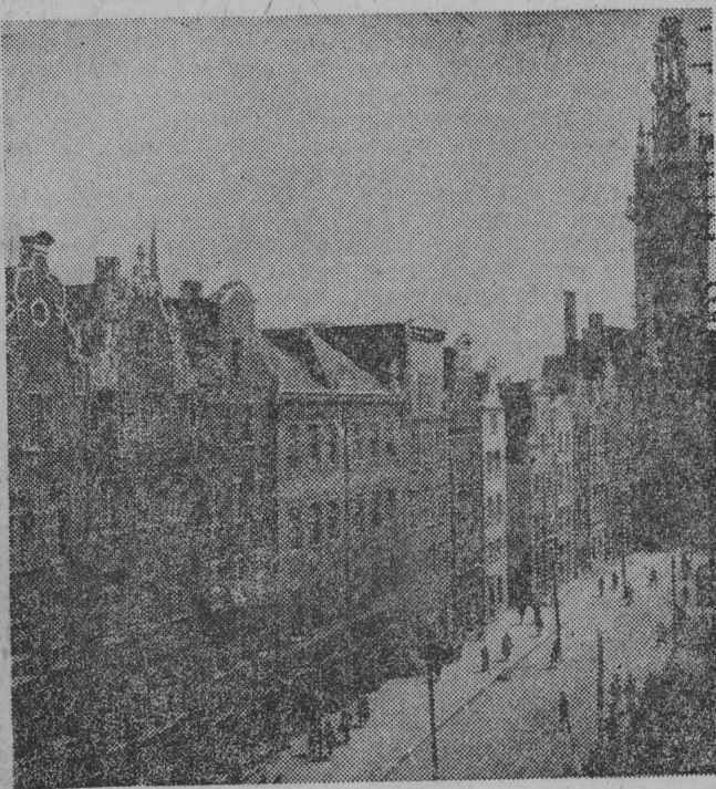
NA ZDJĘCIU: — odbudowane kamieniczki północnej strony ul. Długiej. (CAF — fot. Kosycarz)
