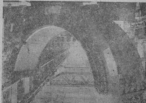
NA ZDJĘCIU: część statora jednego z dwóch hydrogeneratorów dla będącej obecnie w budowie Dubossarskiej Elektrowni Wodnej na Dniestrze (Moldawska SRR). Te potężne hydrogeneratory produkuje fabryka „Uratelektroapparat” w Swierdłowsku.
