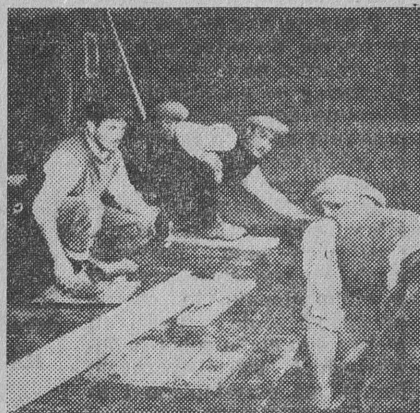
Na budowie PDT zabudowa się obecnie specjalne posadzki. Przy pracy tej zatrudnieni są fachowcy z budów warszawskich. NA ZDJEŚCIU: brygada terakotarzy warszawskich przy pracy.
