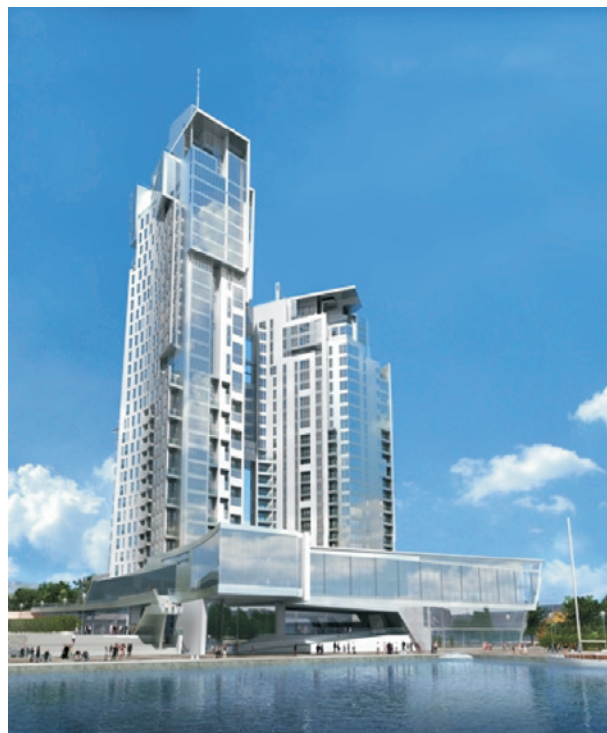
Ryc. 4. Sea Tower w Gdyni, widok od strony Muzeum Morskiego i Zatoki Gdańskiej; fot. autor
