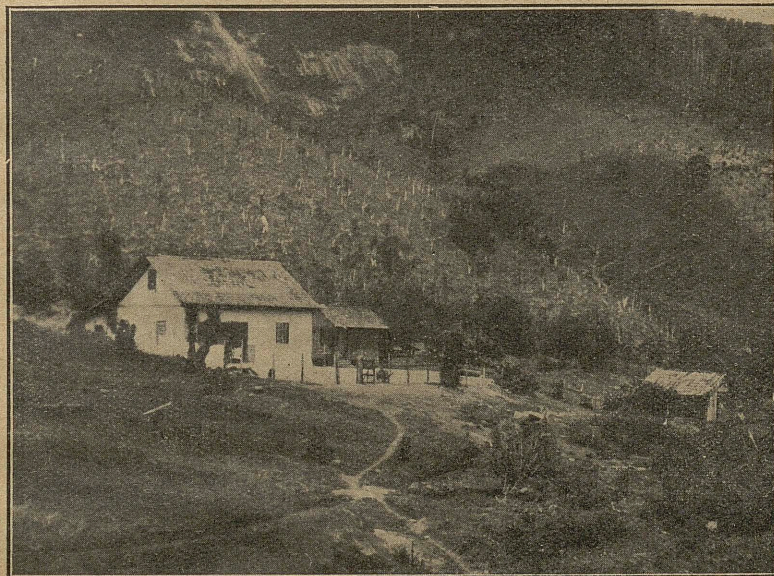
Zabudowania kolonisty Rembińskiego w Alto Baunilha.
