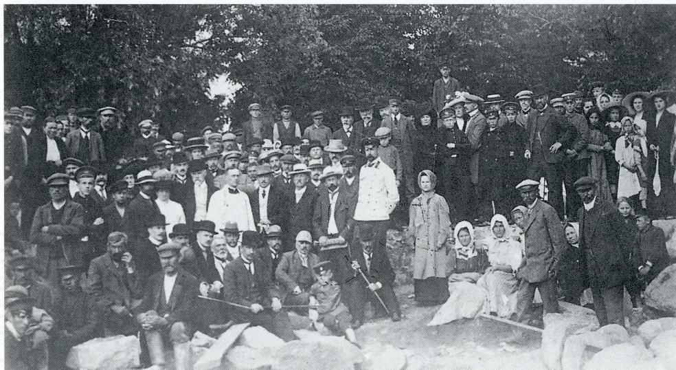
38. Położenie kamienia węgielnego pod gmach Resursy (1912 r.).
