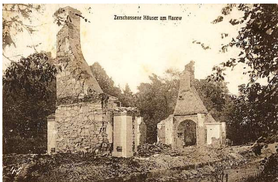
Ruiny domu w Narwi, zniszczonego w czasie przechodzenia frontu w 1915 r.
