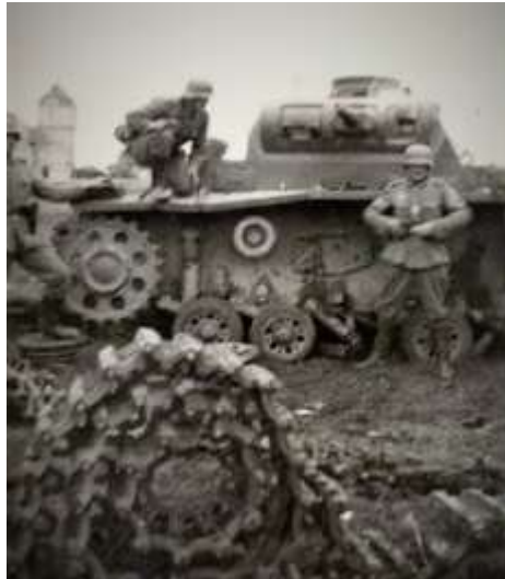
Uszkodzone niemieckie czołgi obok dworca w Bielsku Podlaskim, ok. 20 IX 1939 r.
