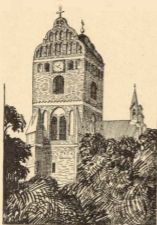
Wieża kościoła N. P. Marji na Nowem Miście.
