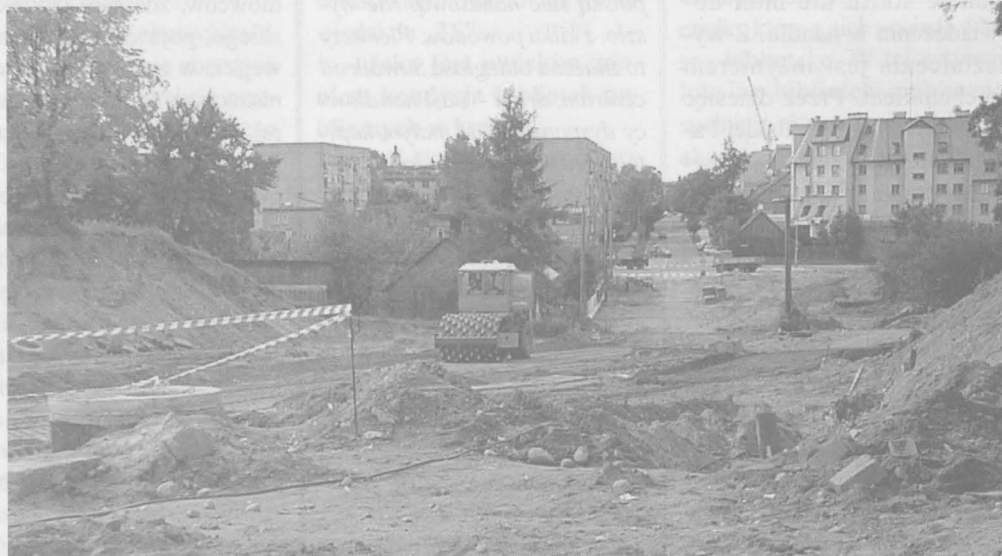
Modernizacja ulicy Bulwarowej
