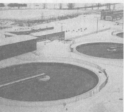
PWiK – oczyszczalnia ścieków.
