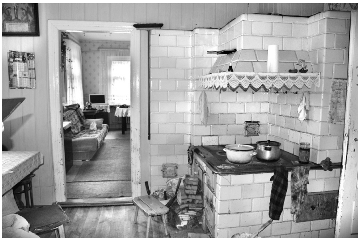
Fig. 13. The main kitchen stove and oven; photo by the authors, 2018 Ryc. 13. Piec kuchenny wielofunkcyjny; fot. autorzy, 2018
