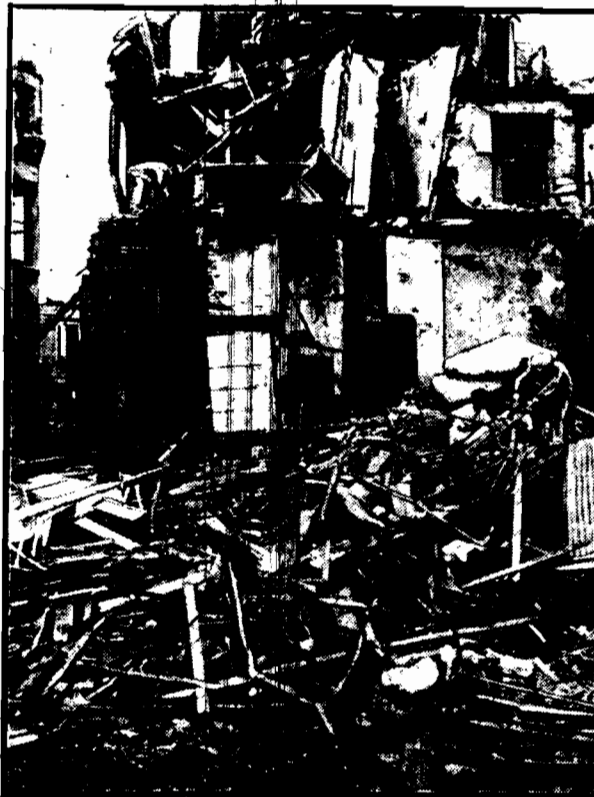
Miasto amerykańskie zniszczone zupełnie przez orkan.
