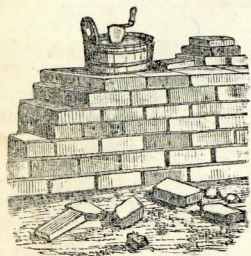
Rys. 243. Mur z cegieł.
