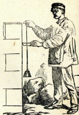
Rys. 236. Mierzenie położenia ściany zapomocą pionu.
