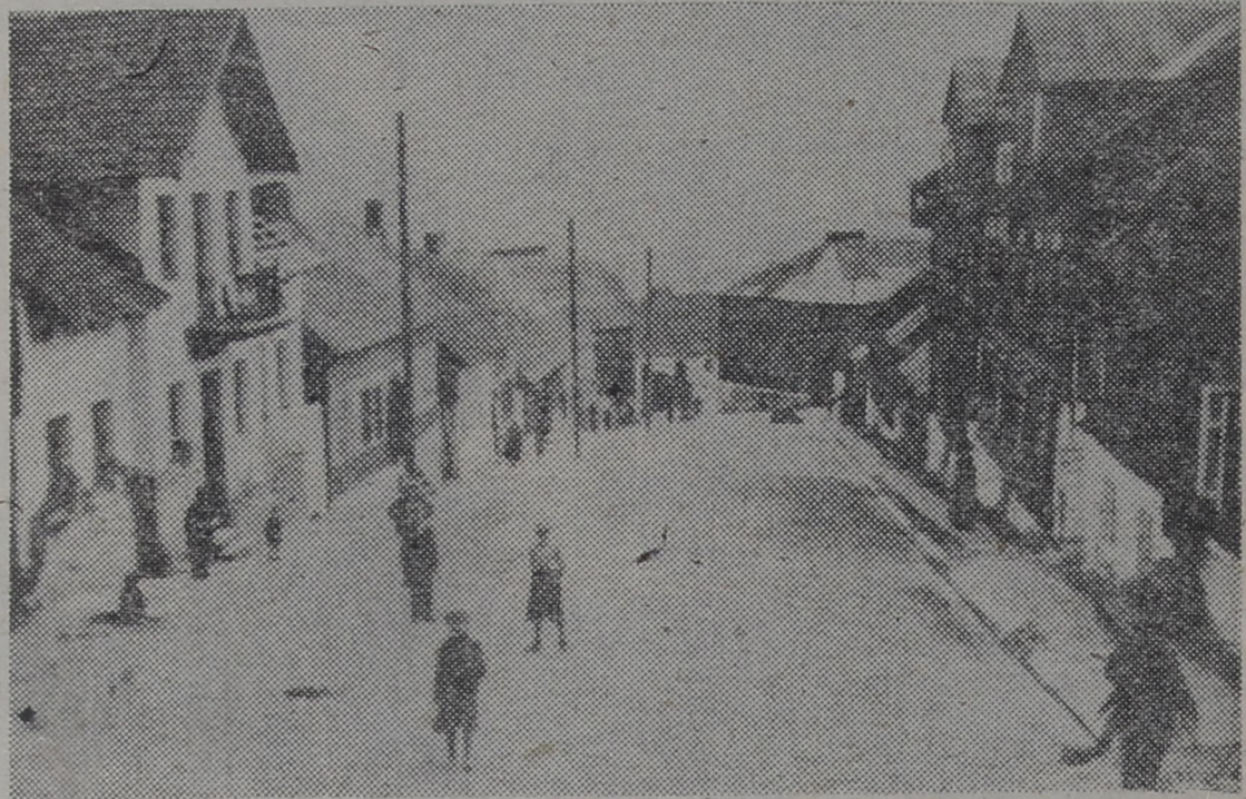
Ulica Żydowska w osiedlu Rybak.
