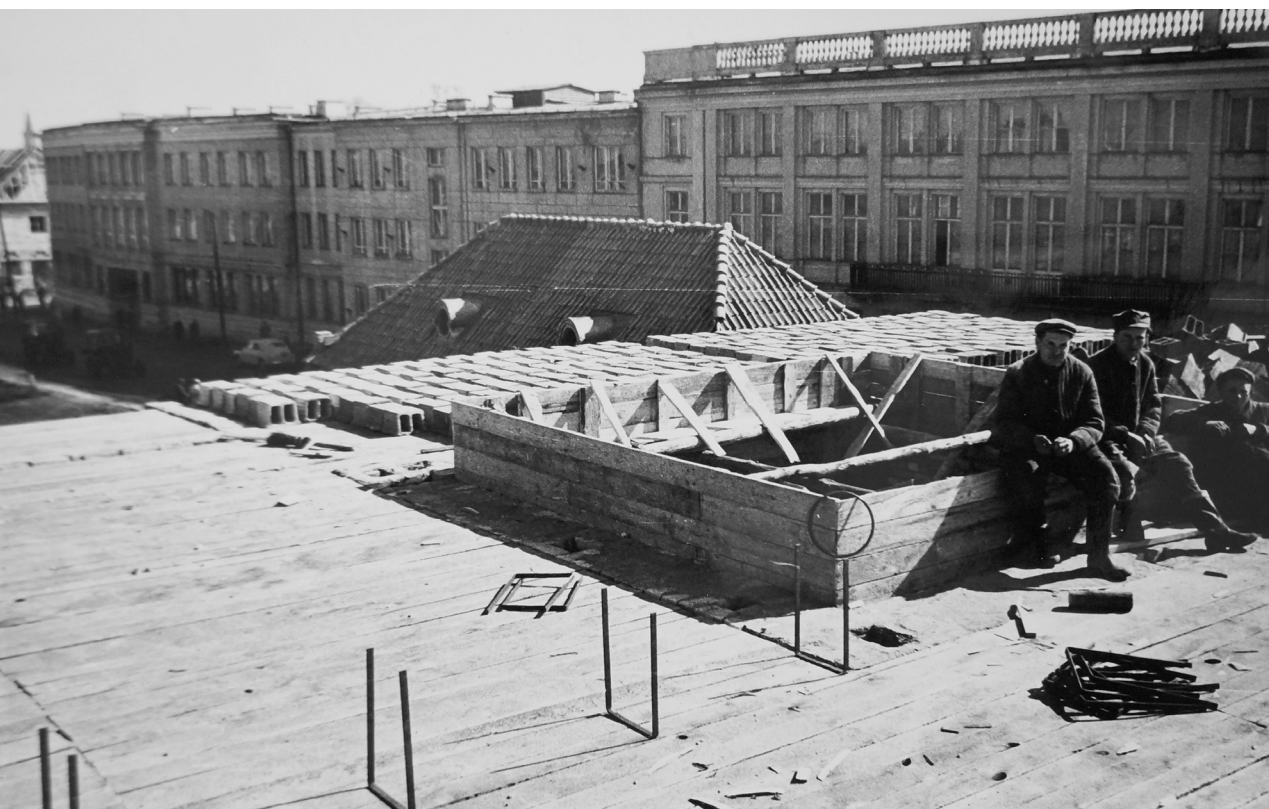
Fotografia 141. Prace rekonstrukcyjne przy stropie korpusu głównego i wieży ratuszowej. Autor zdjęcia: Władysław Paszkowski. Data wykonania: 1956. Oryginał w: WUOZwB
