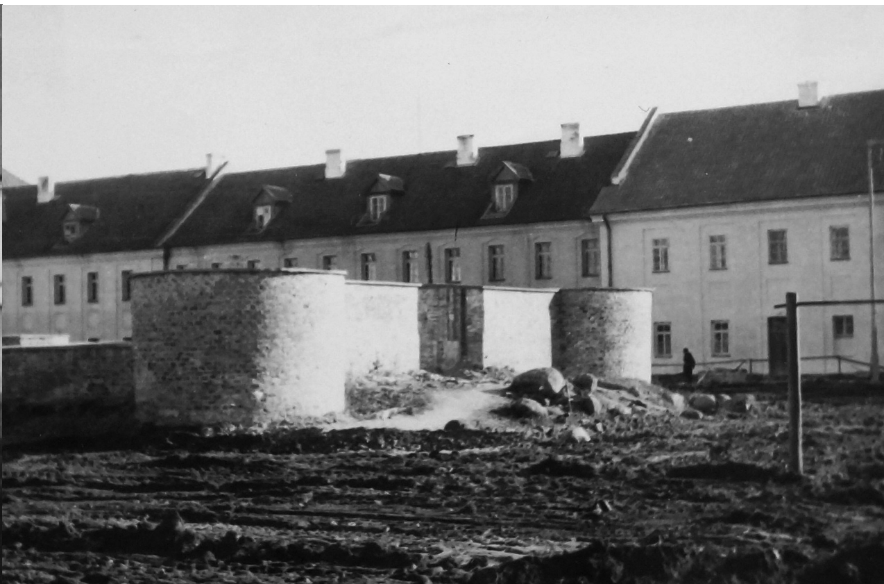
Fotografia 202. Efekt prac zabezpieczających ruiny cerkwi Zwiastowania NMP. Autor zdjęcia: Władysław Paszkowski. Data wykonania: 1962. Oryginał w: WUOZwB
