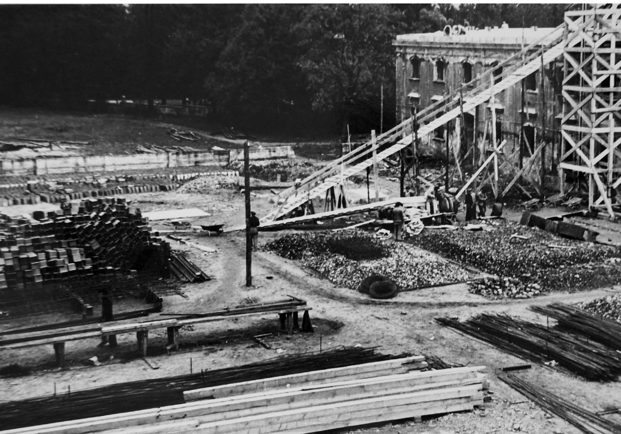
Fotografia 63. Widok na dziedziniec honorowy i lewą (południową) oficynę boczną pałacu.
