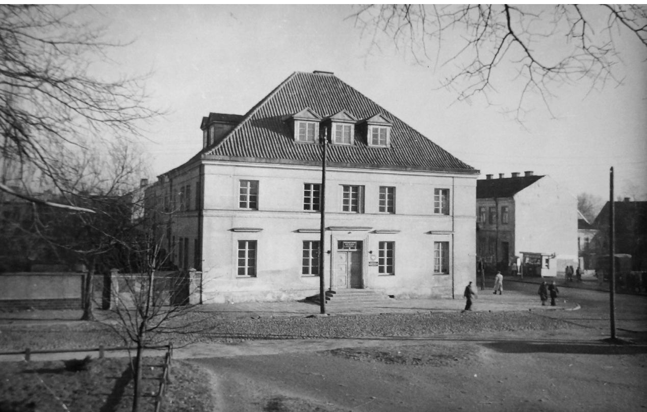
Fotografia 153. Zrekonstruowany budynek loży masońskiej. Widok od strony ul. Kościelnej. Autor zdjęcia: Władysław Paszkowski. Data wykonania: 1953. Oryginał w: WUOZwB
