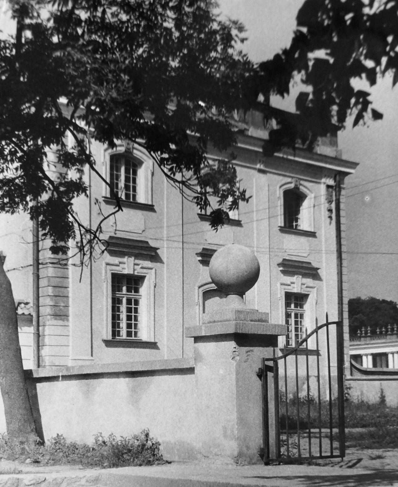
Fotografia 97. Widok od strony ul. Adama Mickiewicza na odbudowaną lewą (południową) oficynę boczną pałacu. Autor zdjęcia: Władysław Paszkowski. Data wykonania: 1957. Oryginał w: WUOZwB
