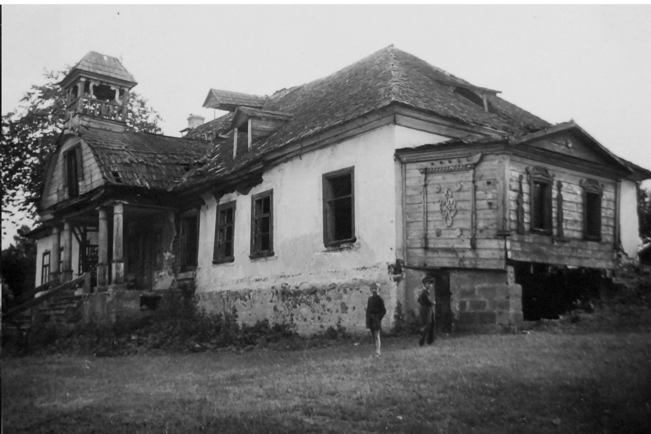
Fotografia 259. Widok na werandę przylegającą do elewacji północnej. Autor zdjęcia: Władysław Paszkowski. Data wykonania: 1947. Oryginał w: WUOZwB
