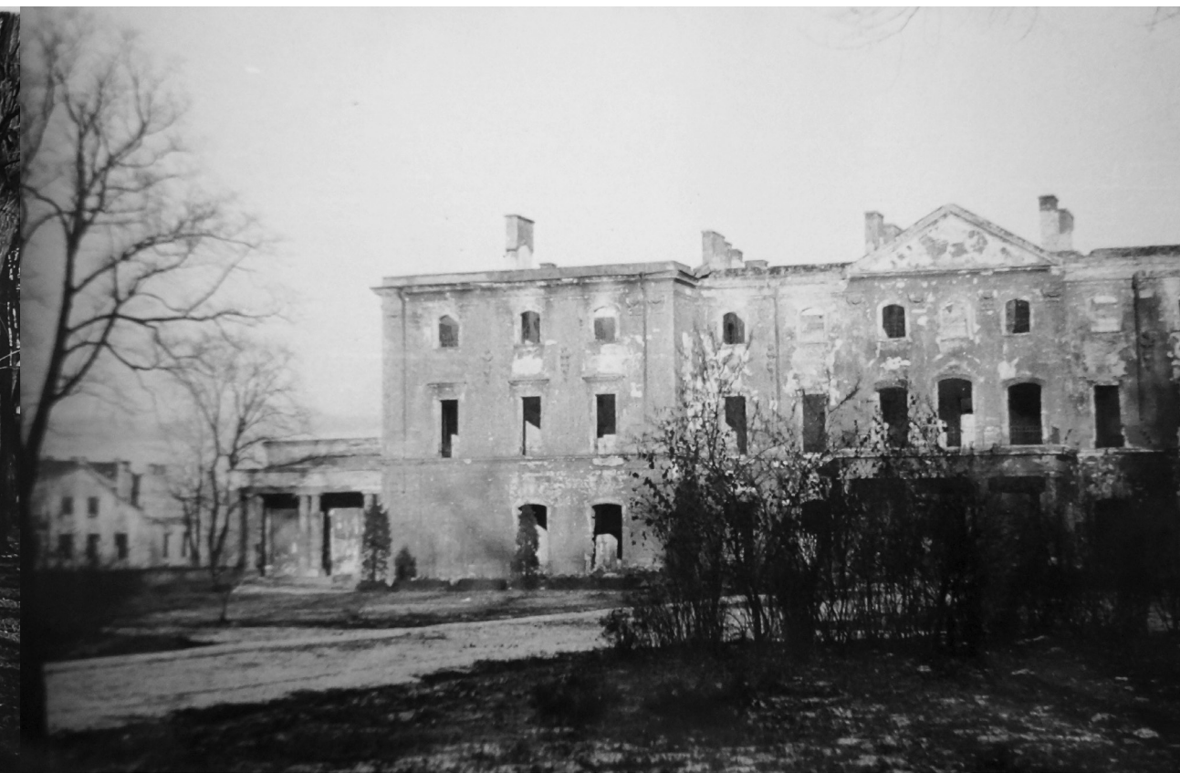
Fotografia 36. Widok na fasadę pałacu od strony ogrodowej w trakcie wycinki drzewostanu.
