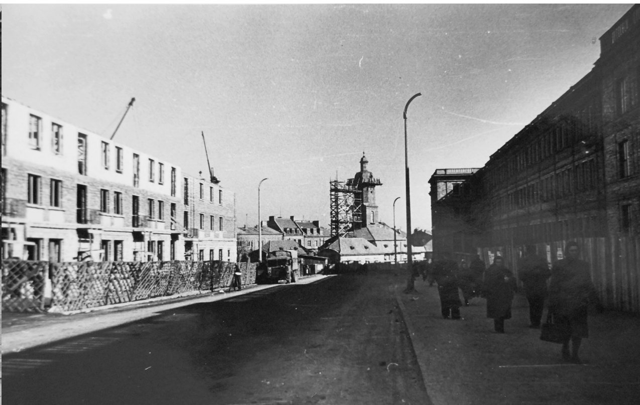
Fotografia 142. Odbudowa wieży ratuszowej. Autor zdjęcia: Władysław Paszkowski. Data wykonania: 1957. Oryginał w: WUOZwB
