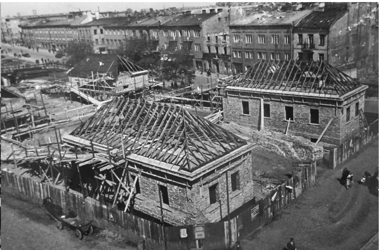
Fotografia 138. Widok na odbudowywane pawilony – alkierze ratuszowe. Autor zdjęcia: Władysław Paszkowski. Data wykonania: 1956. Oryginał w: WUOZwB
