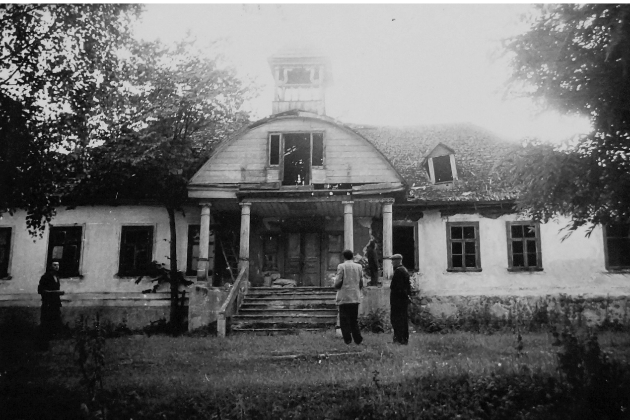
Fotografia 258. Widok na fasadę frontową (wschodnią) z usytuowanym centralnie gankiem z czterema słupami podtrzymującymi półowalny szczyt zwieńczony wieżyczką. Autor zdjęcia: Władysław Paszkowski. Data wykonania: 1947. Oryginał w: WUOZwB
