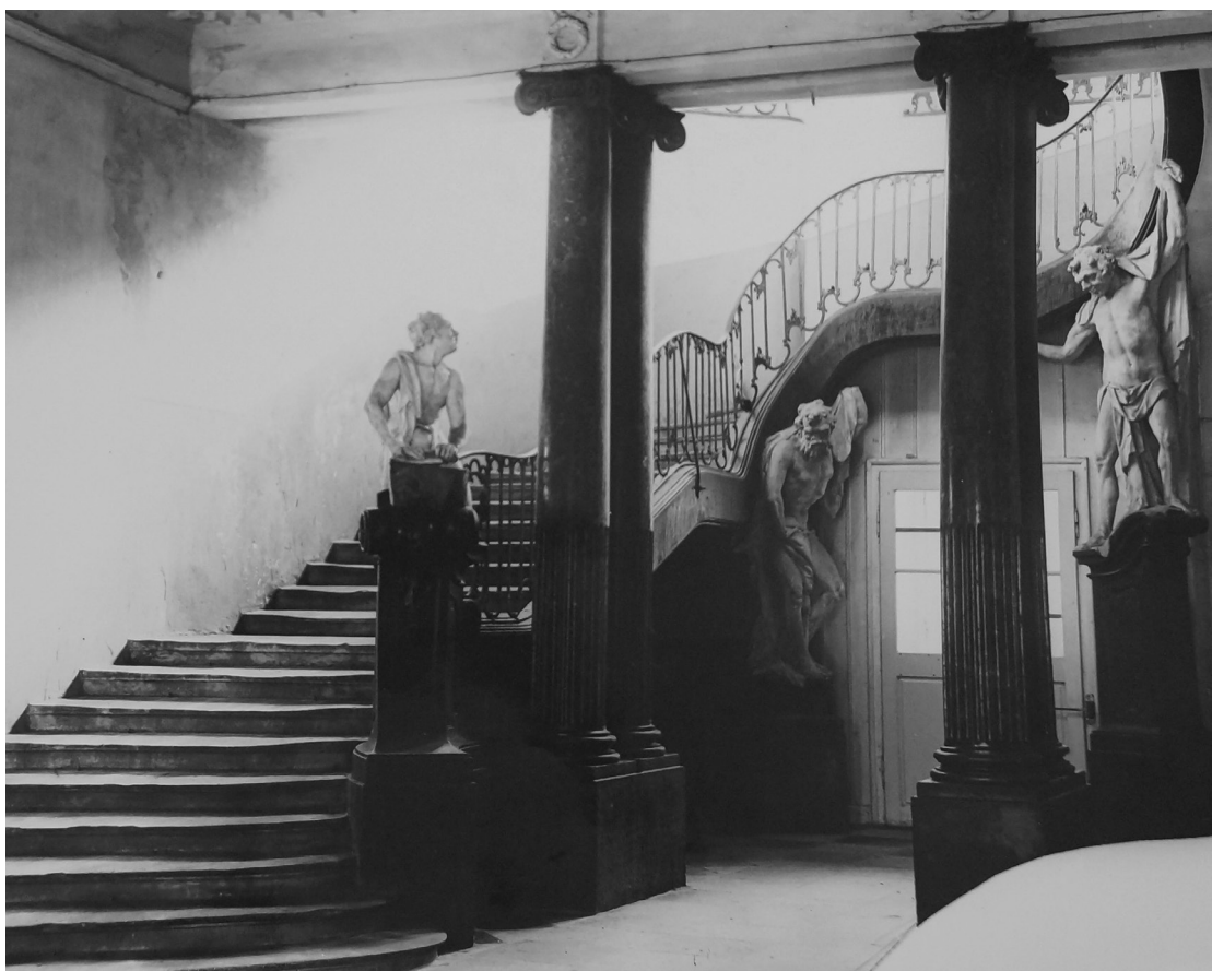
Fotografia 26. Widok na westybul pałacowy z wyeksponowanymi kolumnami oraz rzeźbami Rotatora i dwóch atlantów podtrzymujących paradne schody.
