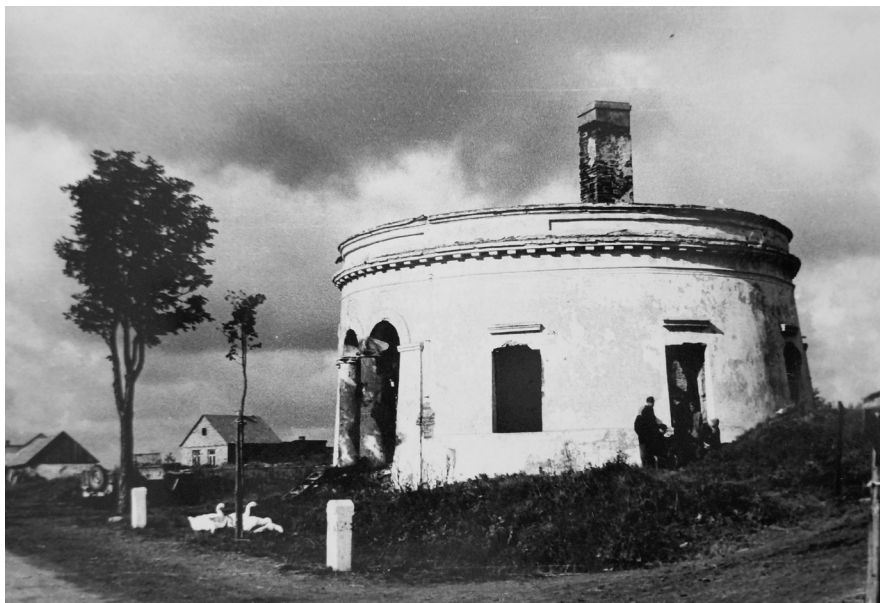
Fotografia 160. Obraz zniszczeń komory celnej. Autor zdjęcia: Władysław Paszkowski. Data wykonania: 1948. Oryginał w: WUOZwB
