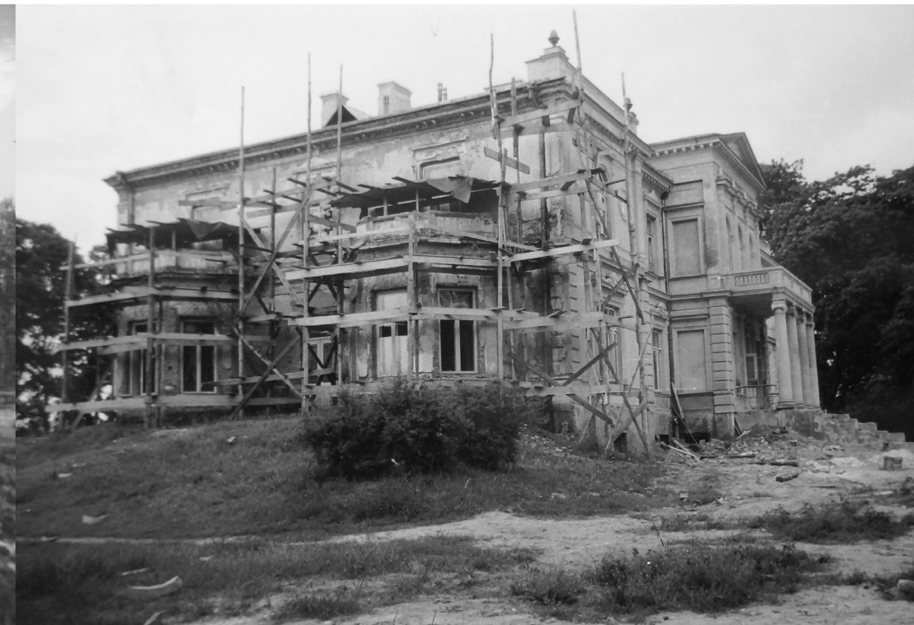
Fotografia 168. Odbudowa pałacu Lubomirskich – widok od strony wschodniej. Autor zdjęcia: Władysław Paszkowski. Data wykonania: 1956. Oryginał w: WUOZwB
