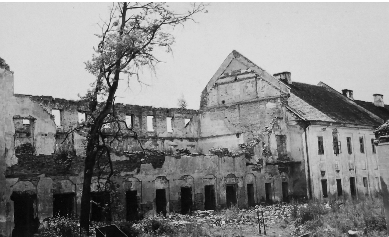
Fotografia 189. Obraz zniszczeń obiektów klasztornych. Autor zdjęcia: Władysław Paszkowski. Data wykonania: 1947. Oryginał w: WUOZwB
