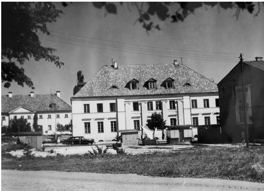
Fotografia 152. Zrekonstruowany budynek loży masońskiej. Widok od strony ul. Kilińskiego. Autor zdjęcia: Władysław Paszkowski.
