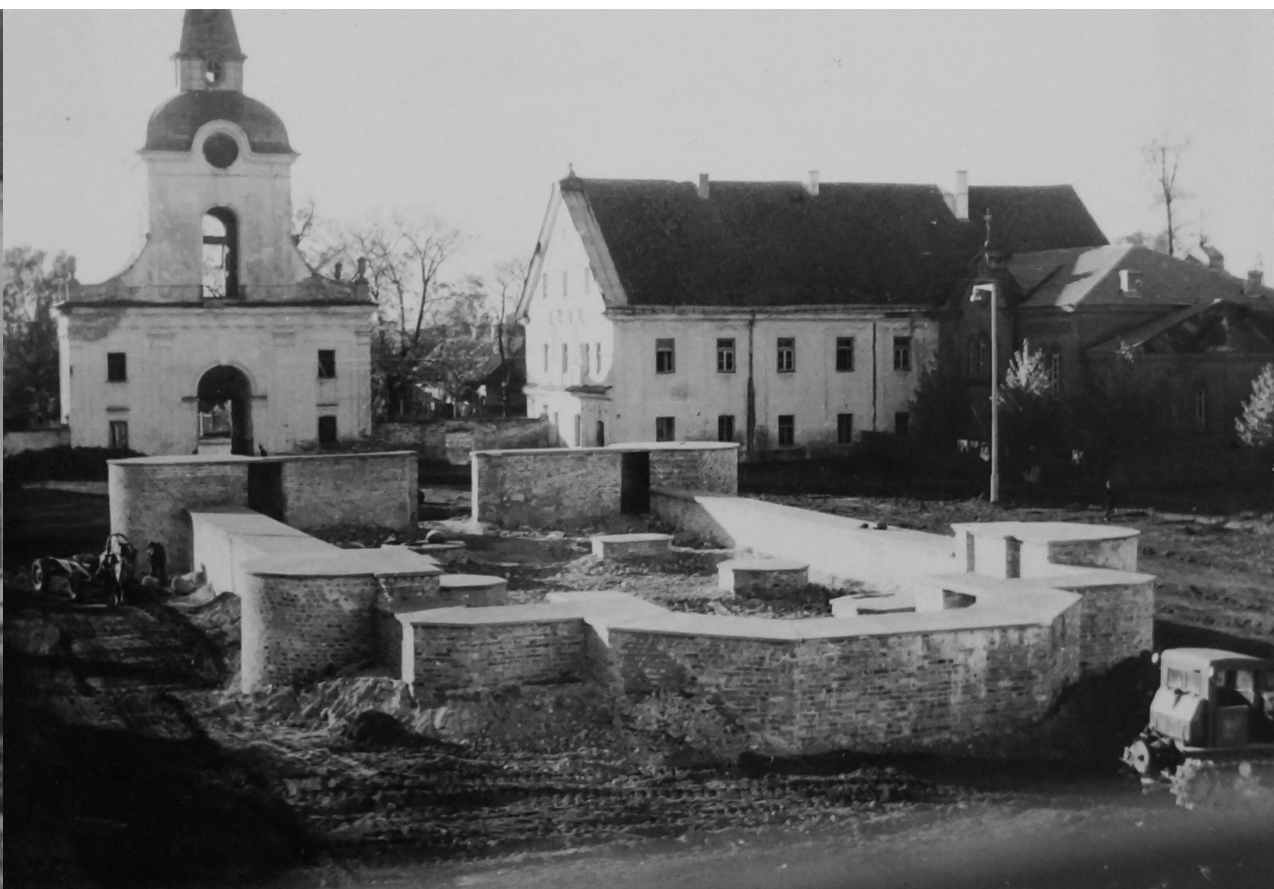
Fotografia 204. Efekt prac zabezpieczających ruiny cerkwi Zwiastowania NMP. Autor zdjęcia: Władysław Paszkowski. Data wykonania: 1962. Oryginał w: WUOZwB
