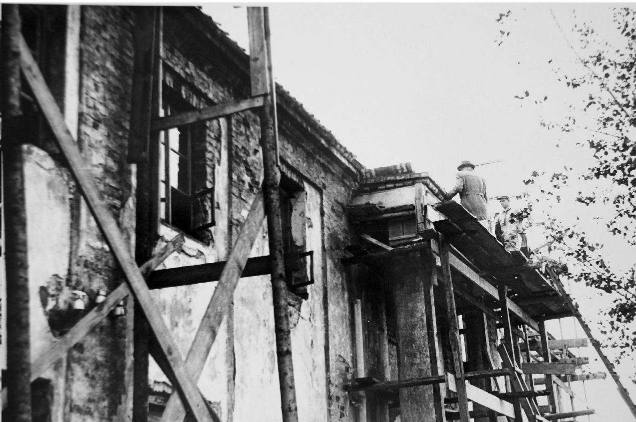
Fotografia 74. Kontrola nadzoru konserwatorskiego nad realizacją prac rekonstrukcyjnych pałacu. Autor zdjęcia: Władysław Paszkowski. Data wykonania: 1948. Oryginał w: WUOZwB
