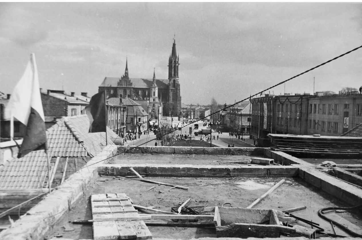
Fotografia 137. Widok na Rynek Kościuszki z poziomu stropu korpusu głównego odbudowywanego ratusza. Autor zdjęcia: Władysław Paszkowski. Data wykonania: 1956. Oryginał w: WUOZwB
