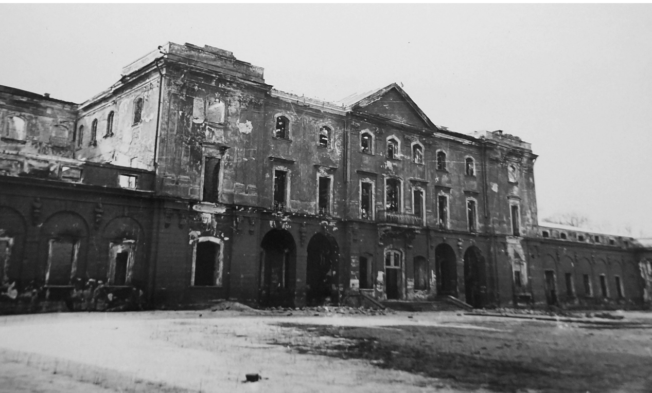
Fotografia 27. Widok na fasadę pałacu od strony dziedzińca honorowego. Autor zdjęcia: Władysław Paszkowski. Data wykonania: 1946. Oryginał w: WUOZwB
