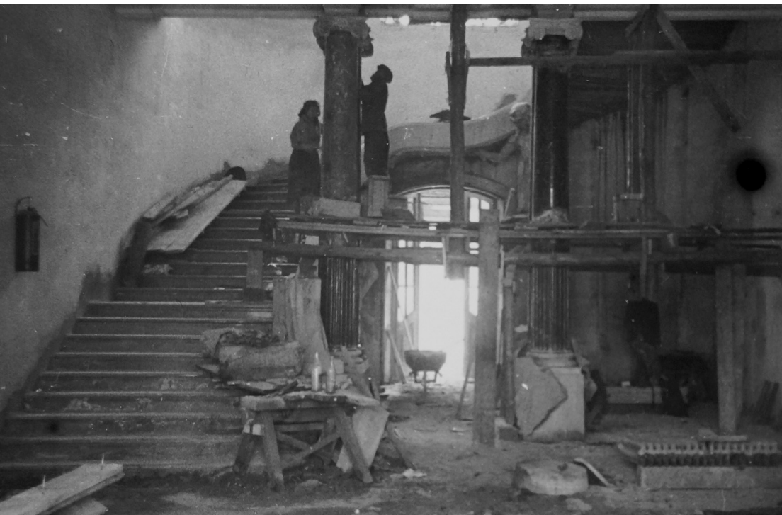
Fotografia 83. Robotnicy pracujący przy rekonstrukcji wnętrz pałacowych. Autor zdjęcia: Władysław Paszkowski. Data wykonania: 1954. Oryginał w: WUOZwB
