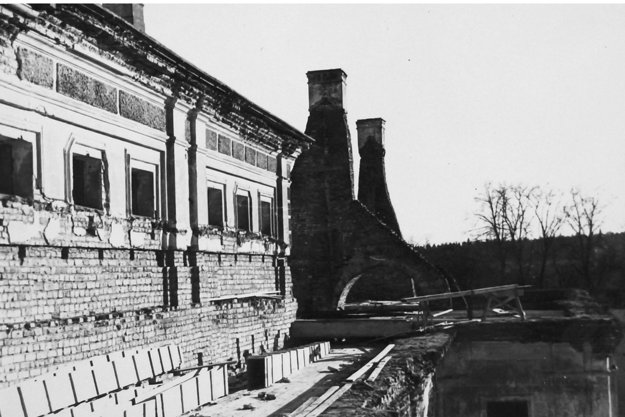
Fotografia 193. Obraz zniszczeń obiektów klasztornych. Autor zdjęcia: Władysław Paszkowski. Data wykonania: 1947. Oryginał w: WUOZwB
