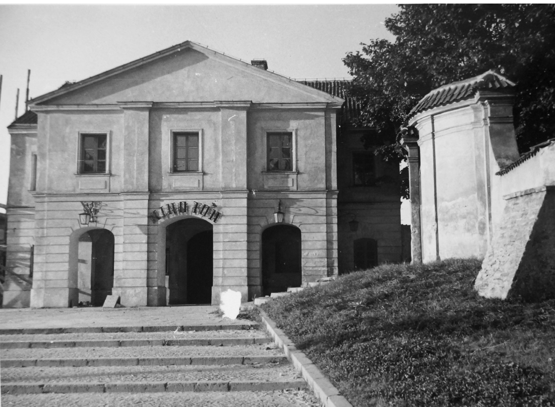
Fotografia 155. Widok na budynek XVIII-wiecznego szpitala poddanego pierwotnej przebudowie w połowie lat 30., a wtórnie na początku lat 50. XX w. Autor zdjęcia:
