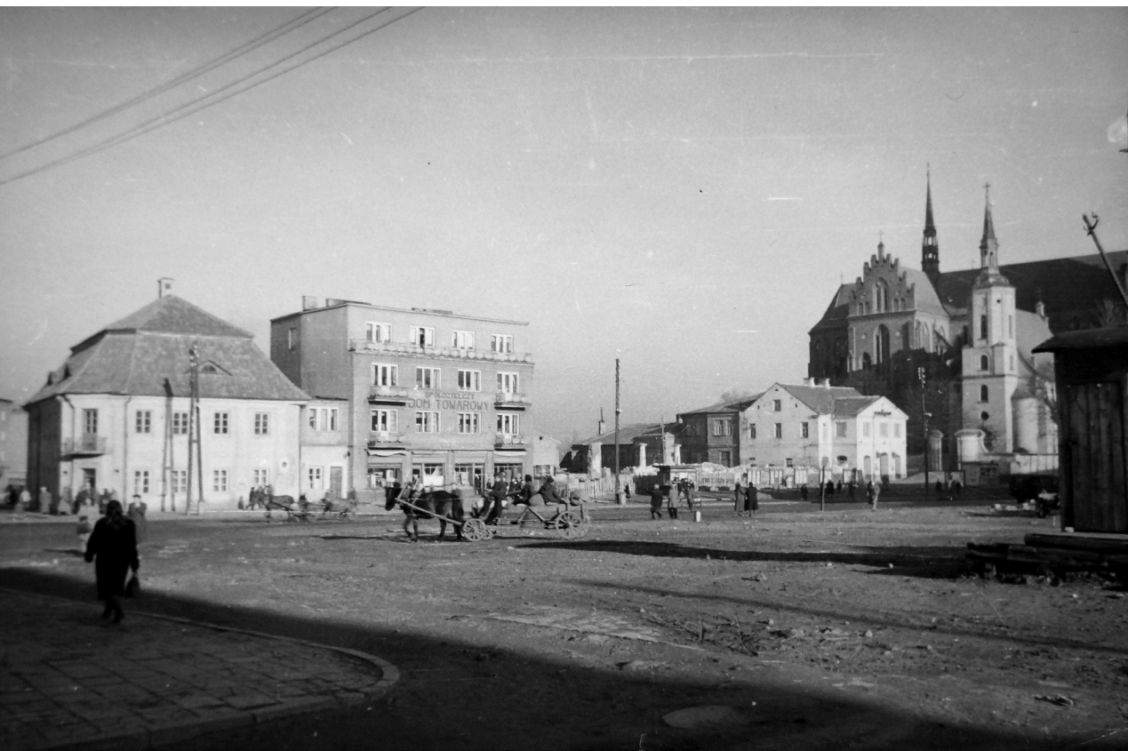
Fotografia 127. Rejon północnej pierzei Rynku Kościuszki w trakcie odbudowy. Autor zdjęcia: Władysław Paszkowski. Data wykonania: 1953. Oryginał w: WUOZwB
