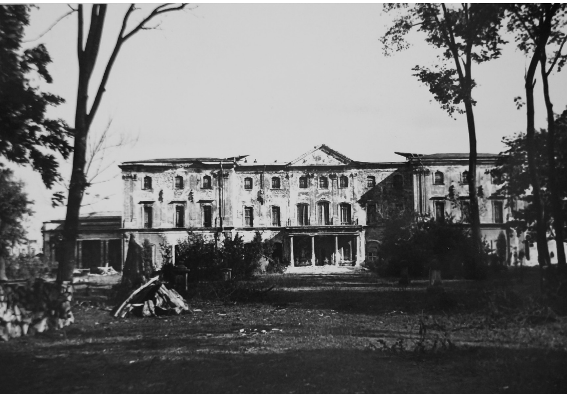
Fotografia 37. Widok na fasadę pałacu od strony ogrodowej w trakcie wycinki drzewostanu.
