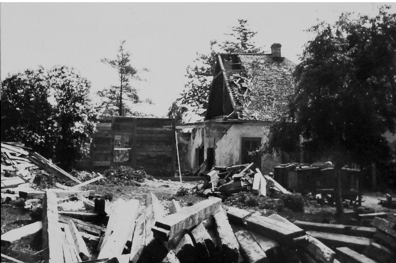
Fotografia 267. Widok dworku w trakcie rekonstrukcji. Autor zdjęcia: Władysław Paszkowski. Data wykonania: 1960. Oryginał w: WUOZwB
