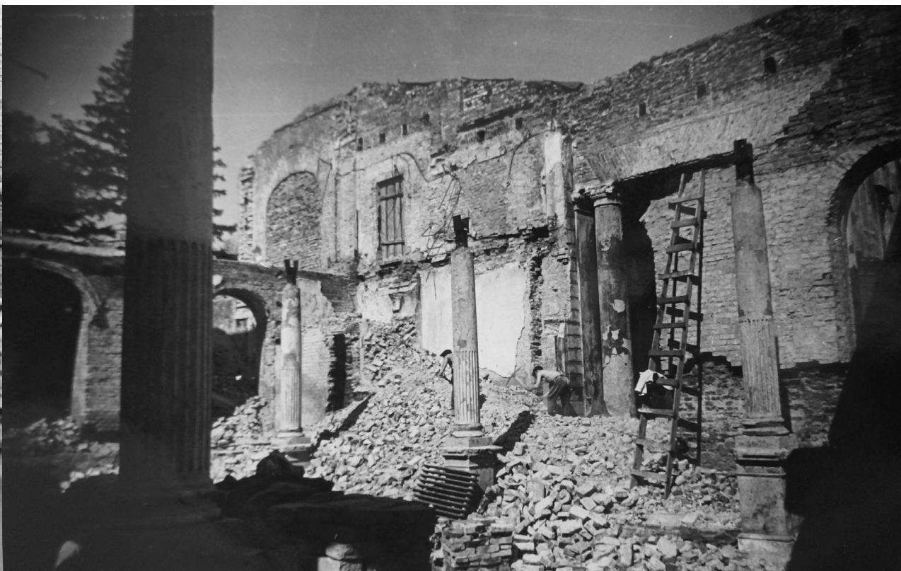
Fotografia 56. Obraz zniszczeń wewnątrz pałacowych. Autor zdjęcia: Władysław Paszkowski. Data wykonania: 1946. Oryginał w: WUOZwB
