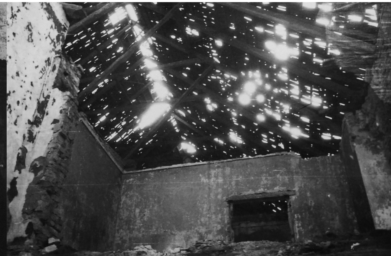
Fotografia 271. Obraz zniszczeń dachu i wnętrz pałacowych. Autor zdjęcia: Władysław Paszkowski. Data wykonania: 1947. Oryginał w: WUOZwB
