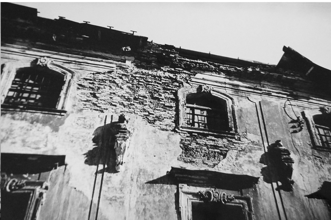
Fotografia 42. Szczegółowy obraz zniszczeń fasady ogrodowej na wysokości ryzalitu. Autor zdjęcia: Władysław Paszkowski. Data wykonania: 1948. Oryginał w: WUOZwB
