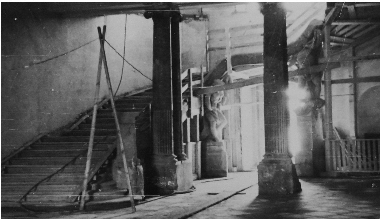
Fotografia 84. Pierwsze efekty rekonstrukcji wnętrz pałacowych. Autor zdjęcia: Władysław Paszkowski. Data wykonania: 1954. Oryginał w: WUOZwB
