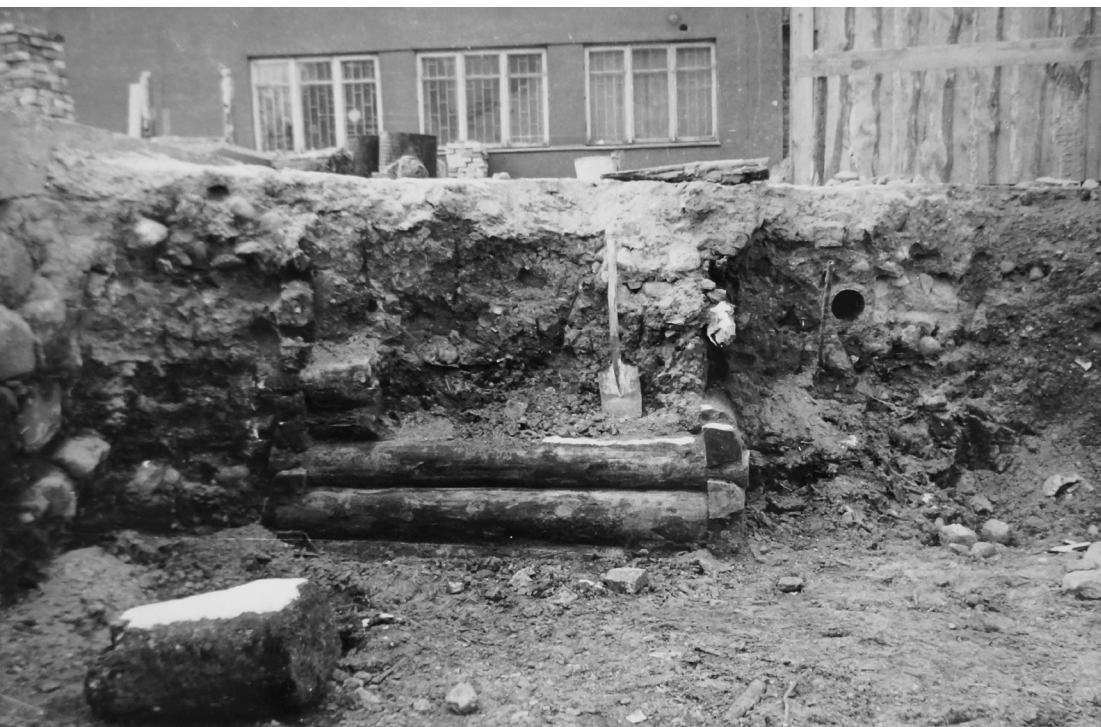
Fotografia 131. Odkrycie pod zniszczoną zbrojownią Branickich przy Rynku Kościuszki pozostałości wcześniejszej zabudowy drewnianej. Autor zdjęcia: Władysław Paszkowski. Data wykonania: 1953. Oryginał w: WUOZwB
