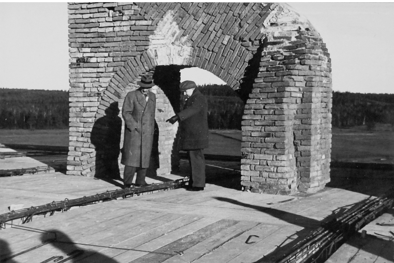
Fotografia 4. Supraśl 1947. Przy odbudowie pałacu Opatów
