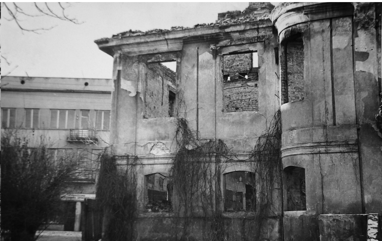
Fotografia 122. Widok na zniszczony Pałac Gościński. W tle modernistyczny budynek, który ocalał z wojennej hekatombi. Autor zdjęcia: Władysław Paszkowski. Data wykonania: 1946. Oryginał w: WUOZwB
