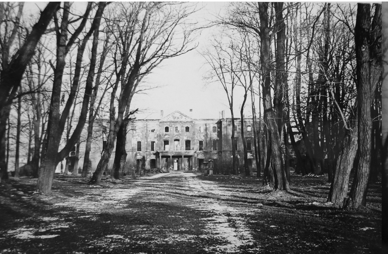
Fotografia 35. Widok na fasadę pałacu od strony ogrodowej przed wycinką drzewostanu.
