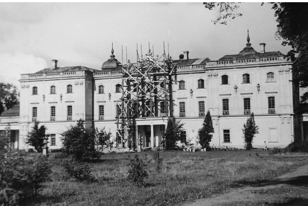
Fotografia 77. Widok w szerokiej perspektywie na rekonstruowaną fasadę ogrodową pałacu.
