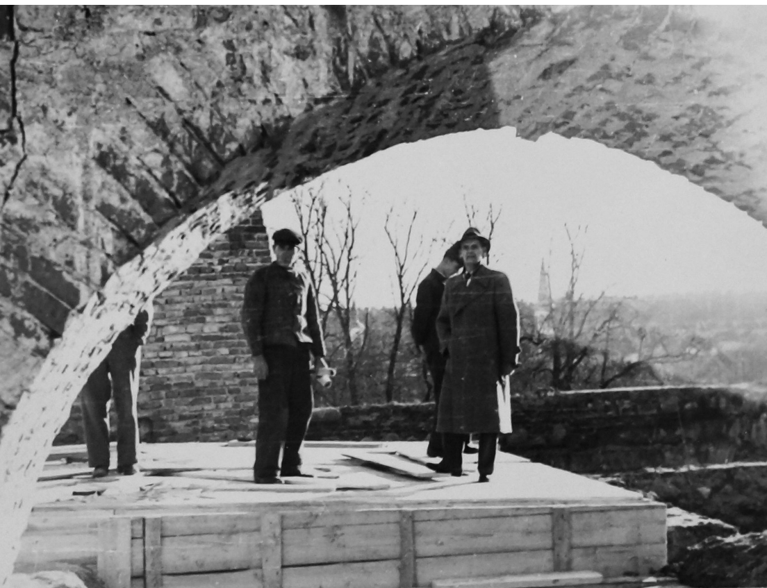
Fotografia 2. Supraśl 1947. Przy odbudowie pałacu Opatów
