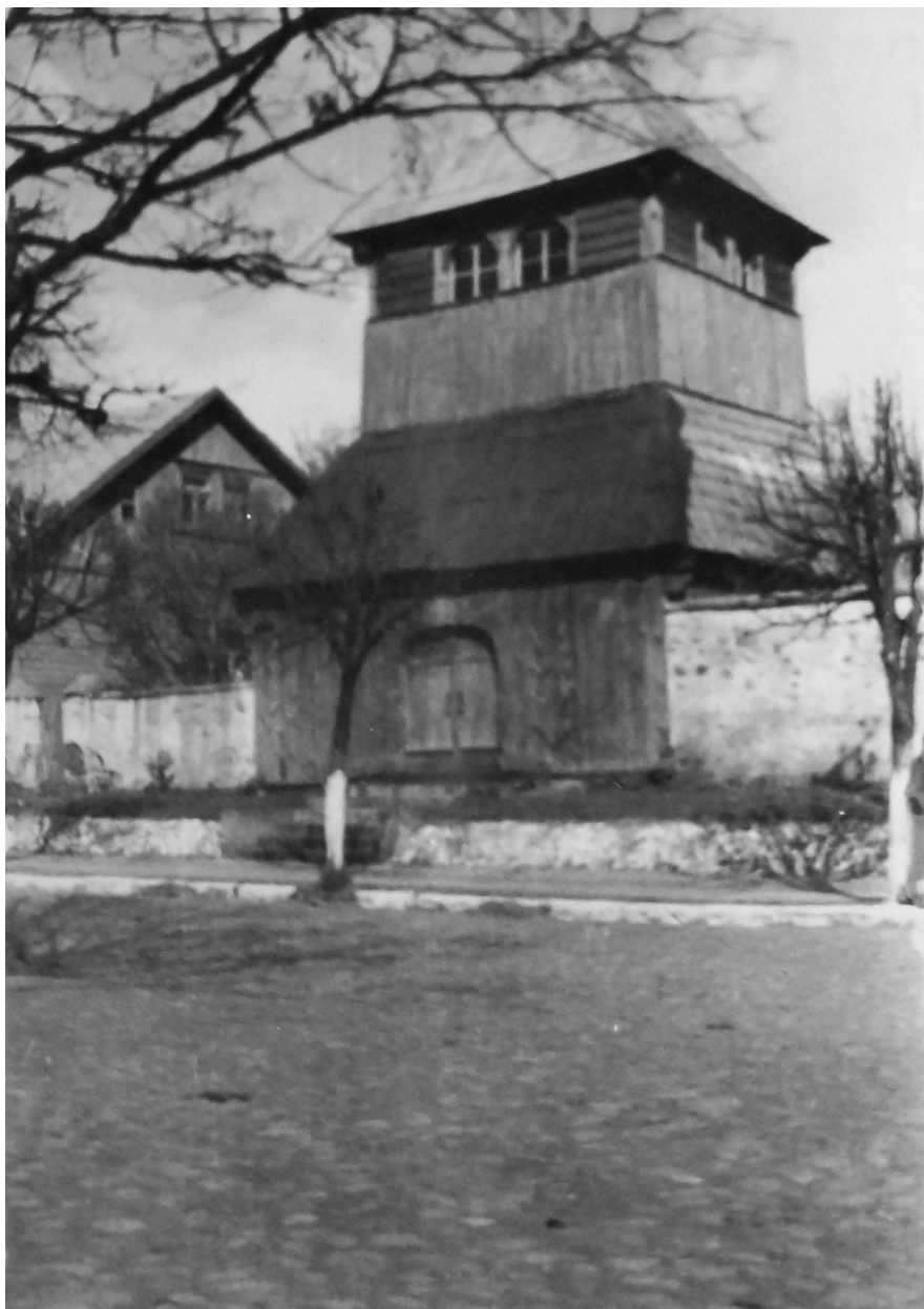
Fotografia 231. Widok od ulicy na drewnianą dzwonnice wieńczoną o konstrukcji słupowej, szalowaną deskami i zwieńczoną dachem namiotowym. Autor zdjęcia: Władysław Paszkowski. Data wykonania: 1956. Oryginał w: WUOZwB
