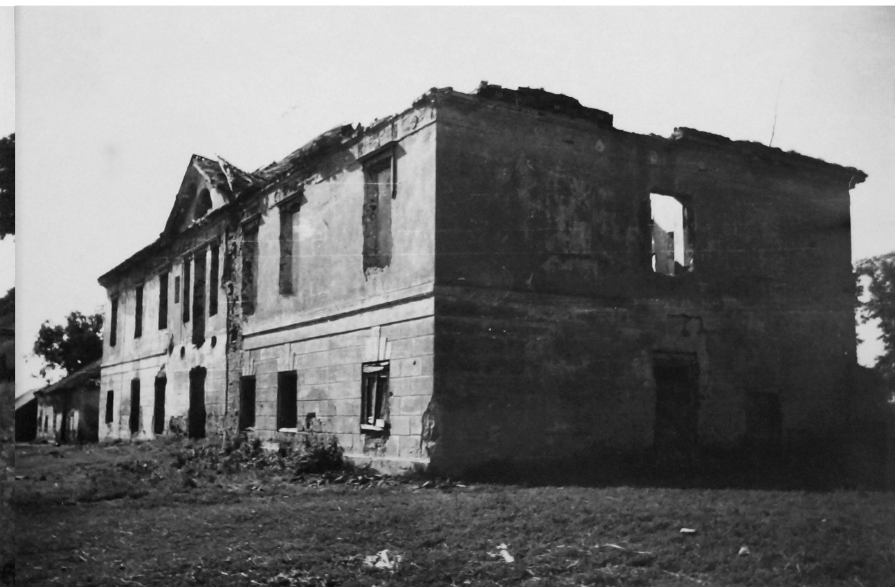
Fotografia 269. Widok na zniszczoną pałacową fasadę frontową (wschodnią) i elewację boczną (północną). Autor zdjęcia: Władysław Paszkowski. Data wykonania: 1947. Oryginał w: WUOZwB
