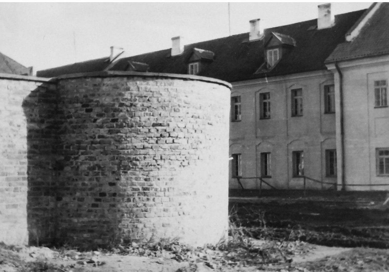
Fotografia 203. Efekt prac zabezpieczających ruiny cerkwi Zwiastowania NMP. Autor zdjęcia: Władysław Paszkowski. Data wykonania: 1962. Oryginał w: WUOZwB
