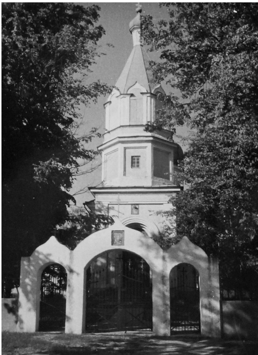
Fotografia 228. Widok na potrójną bramę i trójkondygnacyjną cerkiewną wieżę frontową.
