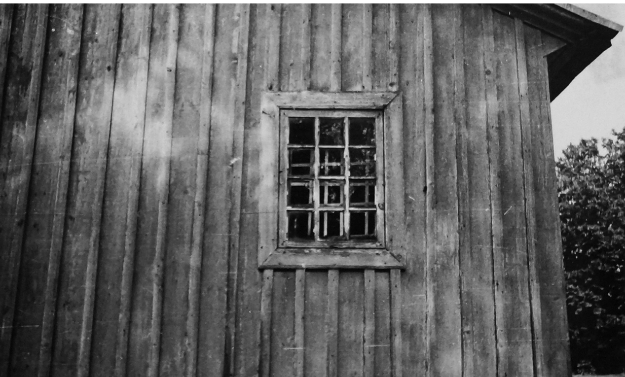
Fotografia 239. Widok na drobnokwaterowe okno zakrystii w ścianie spiętej lisicami i oszalowanej pionowo z listwowaniem. Autor zdjęcia: Władysław Paszkowski. Data wykonania: 1952. Oryginał w: WUOZwB
