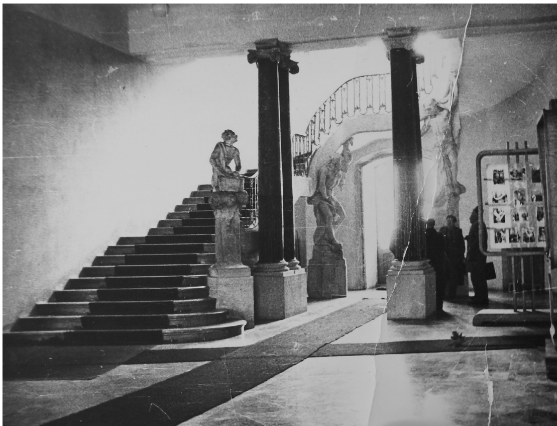
Fotografia 98. Widok na zrekonstruowany westybul pałacowy z wyeksponowanymi kolumnami oraz rzeźbami Rotatora i dwóch atlantów podtrzymujących paradne schody. Autor zdjęcia: Władysław Paszkowski. Data wykonania: 1956. Oryginał w: WUOZwB
