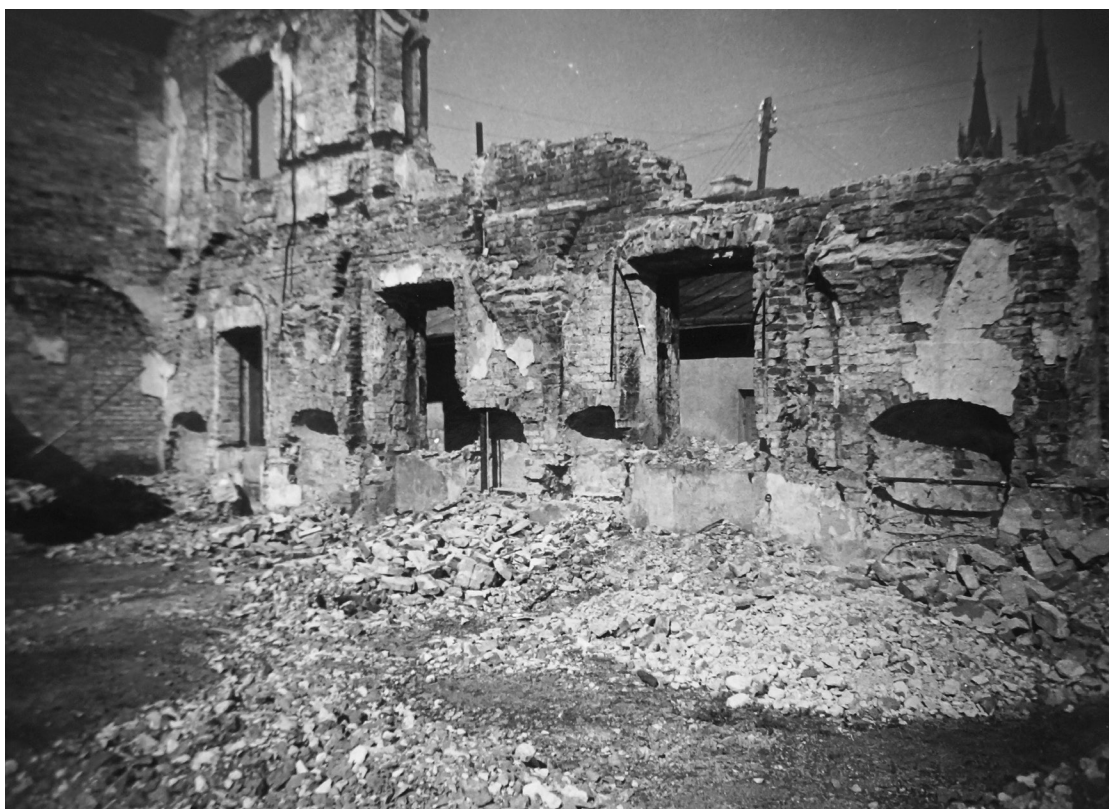
Fotografia 40. Obraz zniszczeń prawej (północnej) oficyny pałacowej. Autor zdjęcia: Władysław Paszkowski. Data wykonania: 1946. Oryginał w: WUOZwB
