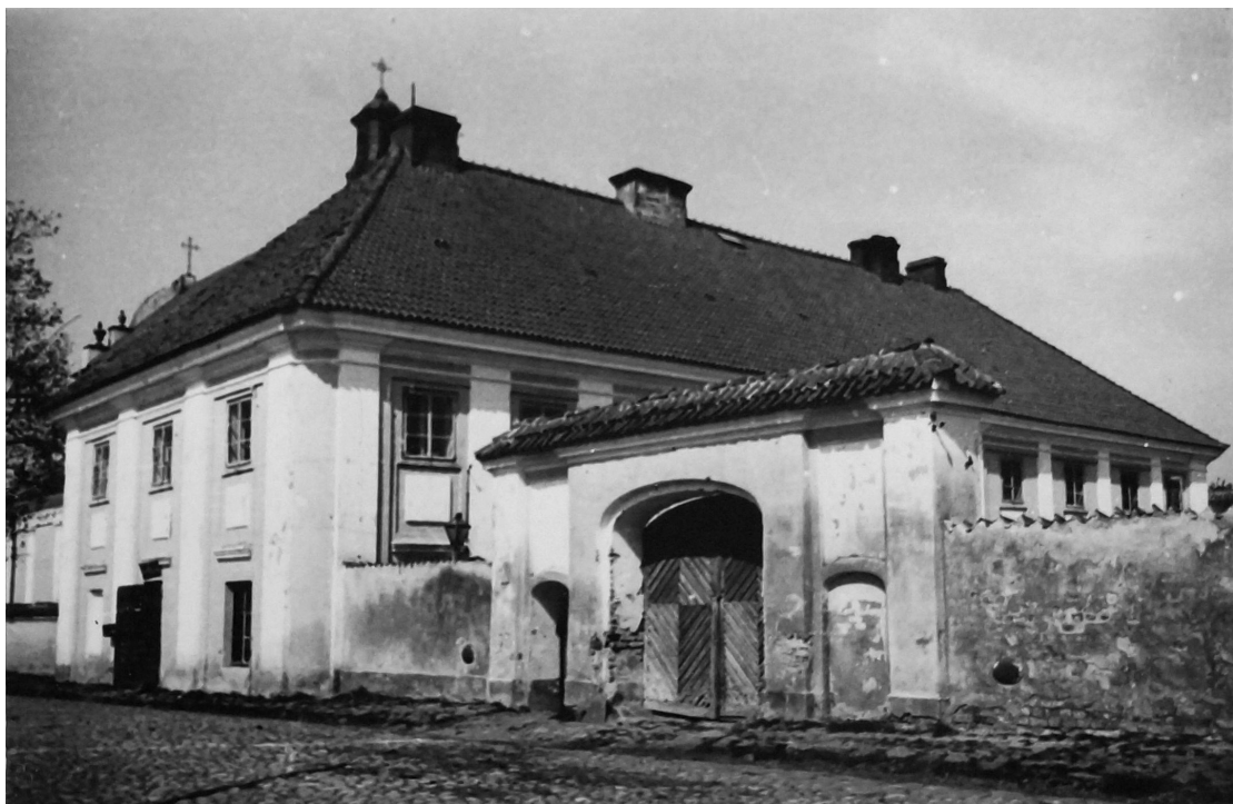
Fotografia 212. Widok na fasadę południową budynku poklasztornego i bramę z otworami zamkniętymi łukami koszowymi. Autor zdjęcia: Władysław Paszkowski. Data wykonania: 1947. Oryginał w: WUOZwB
