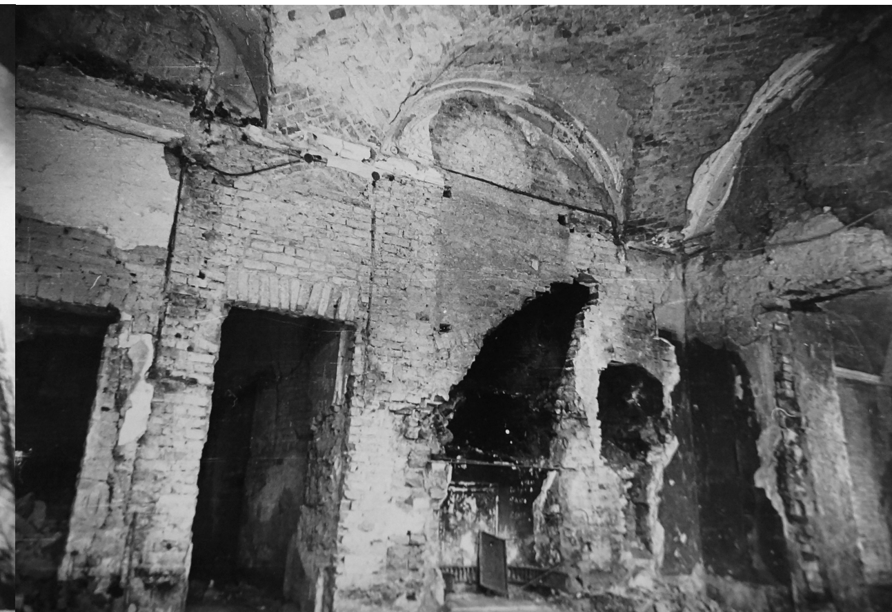
Fotografia 50. Obraz zniszczeń wewnątrz pałacowych. Autor zdjęcia: Władysław Paszkowski. Data wykonania: 1947. Oryginał w: WUOZwB
