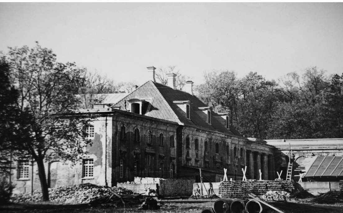
Fotografia 69. Widok od strony dziedzińca honorowego na odbudowywaną lewą (południową) oficynę boczną pałacu. Autor zdjęcia: Władysław Paszkowski. Data wykonania: 1948. Oryginał w: WUOZwB
