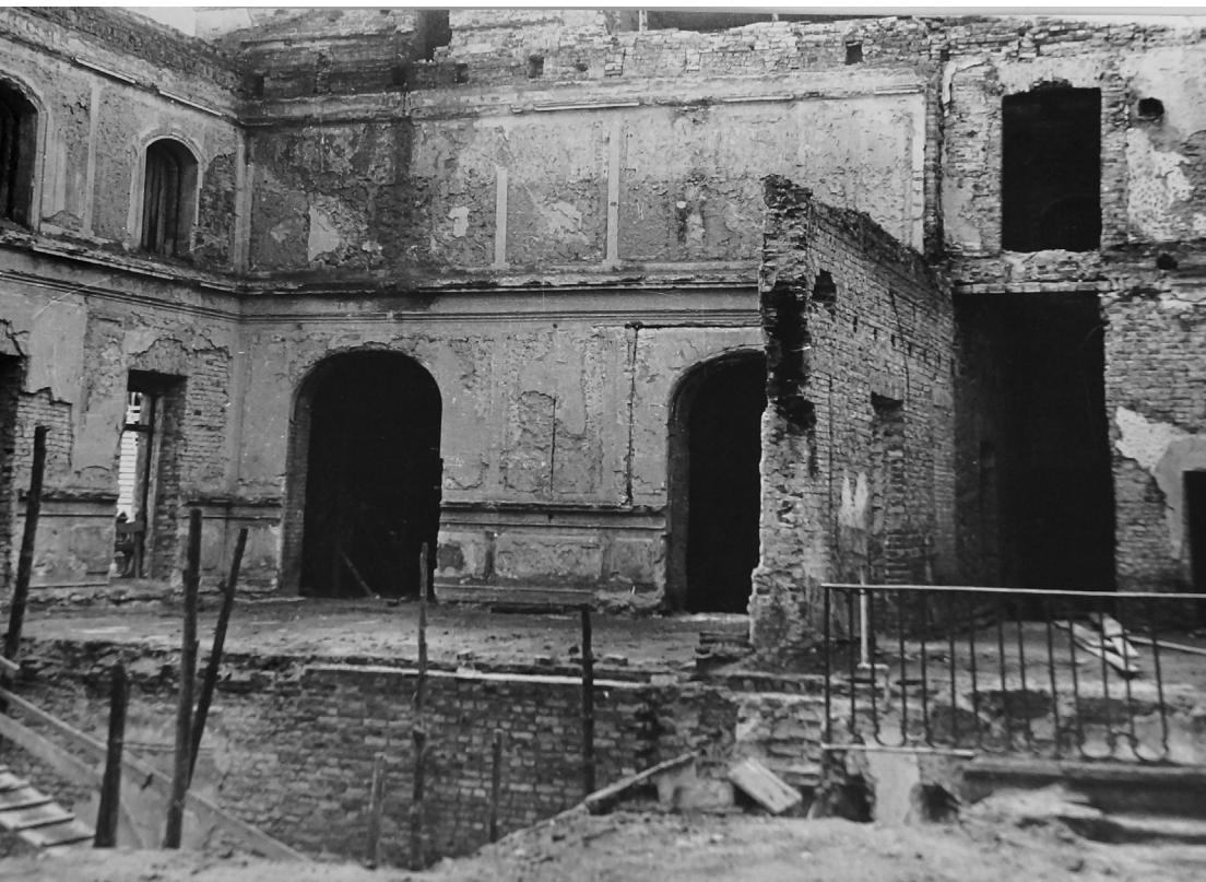
Fotografia 51. Obraz zniszczeń wewnątrz pałacowych. Autor zdjęcia: Władysław Paszkowski. Data wykonania: 1948. Oryginał w: WUOZwB
