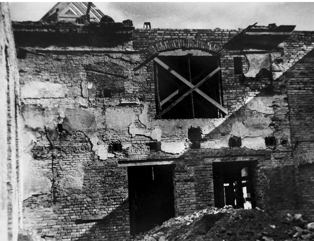
Fotografia 47. Obraz zniszczeń wewnątrz pałacowych. Autor zdjęcia: Władysław Paszkowski. Data wykonania: 1948. Oryginał w: WUOZwB
