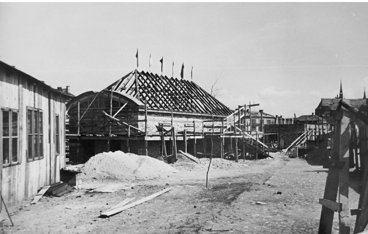
Fotografia 139. Widok na jeden z odbudowywanych pawilonów – alkierzy ratuszowych. Autor zdjęcia: Władysław Paszkowski. Data wykonania: 1956. Oryginał w: WUOZwB
