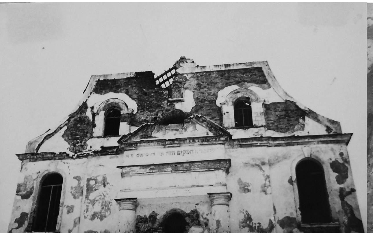
Fotografia 217. Widok z bliskiej perspektywy na zniszczenia fasady zachodniej (frontowej).
