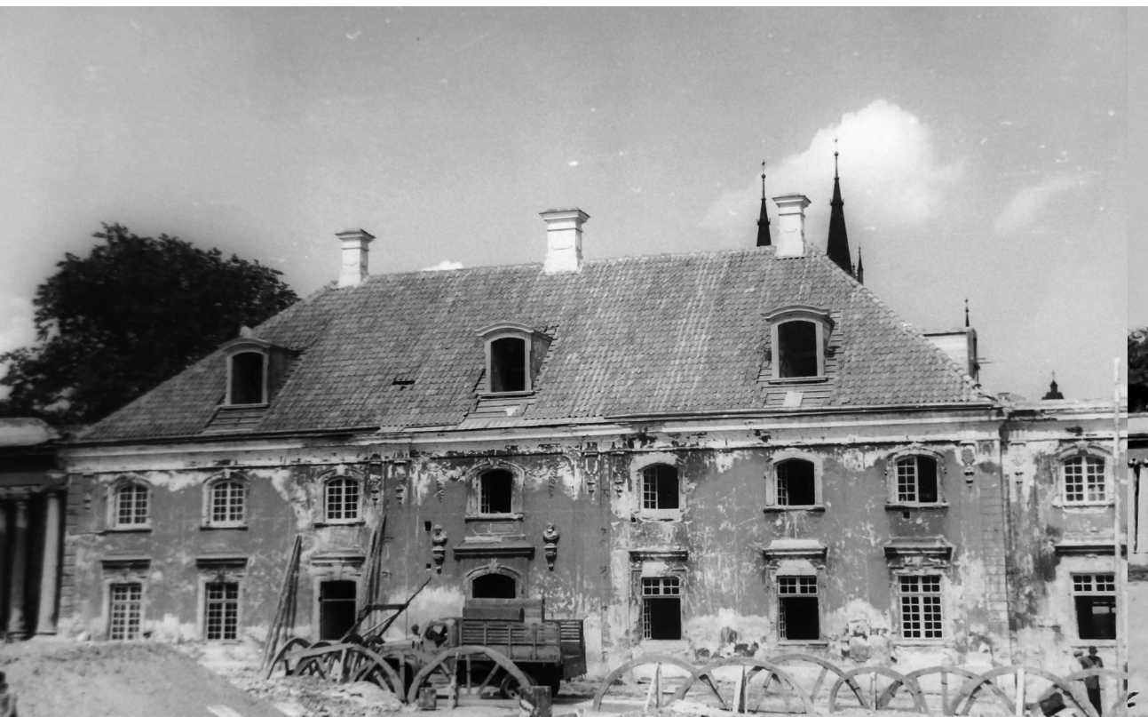
Fotografia 71. Widok z dziedzińca honorowego na rekonstruowaną prawą (północną) oficynę boczną. Autor zdjęcia: Władysław Paszkowski. Data wykonania: 1948. Oryginał w: WUOZwB
