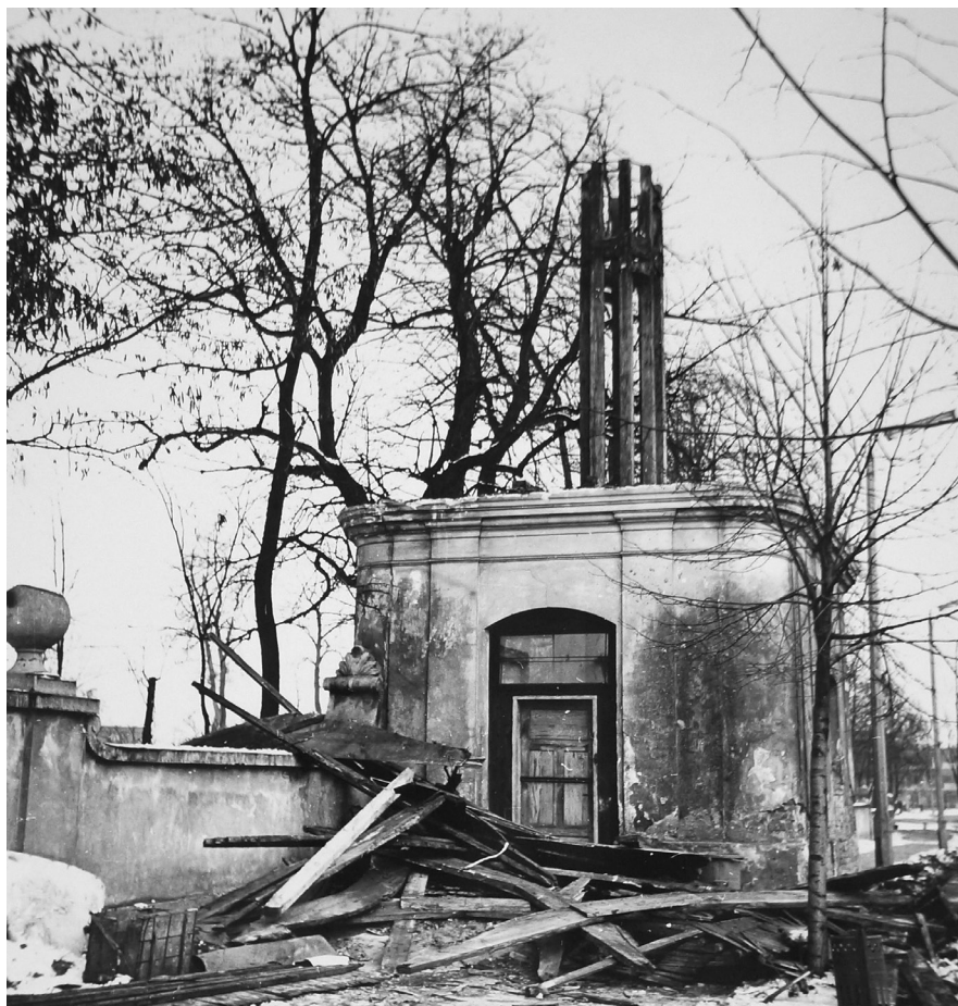
Fotografia 111. Remont lewego (południowego) pawilonu ogrodzeniowego (tzw. studni). Autor zdjęcia: Władysław Paszkowski. Data wykonania: 1972. Oryginał w: WUOZwB
