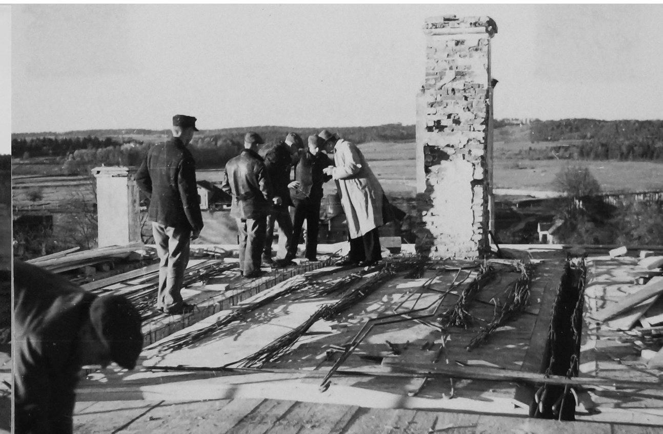
Fotografia 5. Supraśl 1947. Przy odbudowie pałacu Opatów
