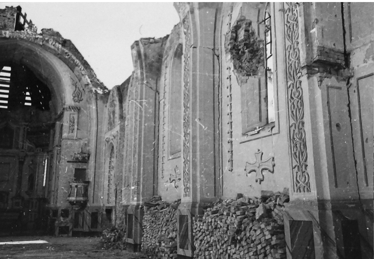
Fotografia 288. Obraz zniszczeń wnętrza świątyni. Autor zdjęcia: Władysław Paszkowski. Data wykonania: 1955. Oryginał w: WUOZwB
