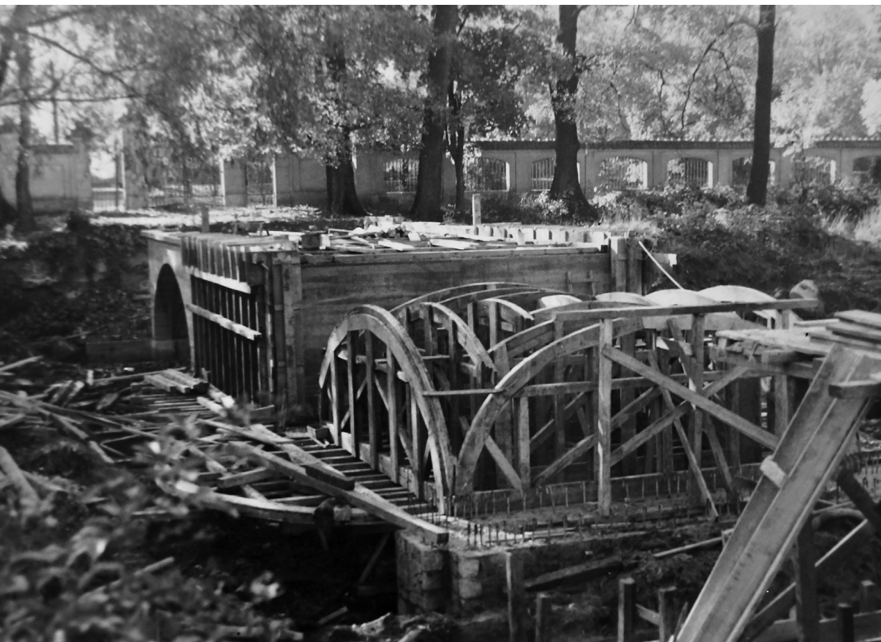
Fotografia 109. Odbudowa pałacowego mostu ogrodowego. Autor zdjęcia: Władysław Paszkowski. Data wykonania: 1967. Oryginał w: WUOZwB
