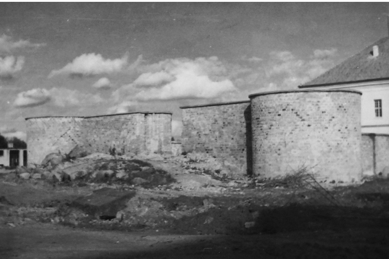
Fotografia 201. Efekt prac zabezpieczających ruiny cerkwi Zwiastowania NMP. Autor zdjęcia: Władysław Paszkowski. Data wykonania: 1962. Oryginał w: WUOZwB
