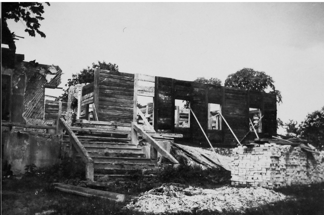
Fotografia 263. Widok fasady frontowej dworku w trakcie rekonstrukcji. Autor zdjęcia: Władysław Paszkowski. Data wykonania: 1960. Oryginał w: WUOZwB
