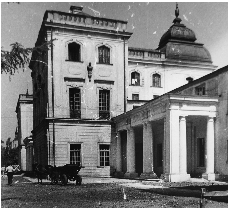
Fotografia 96. Widok na fragment zrekonstruowanej fasady ogrodowej pałacu i hełm lewej (południowej) wieży. Autor zdjęcia: Władysław Paszkowski. Data wykonania: 1956. Oryginał w: WUOZwB
