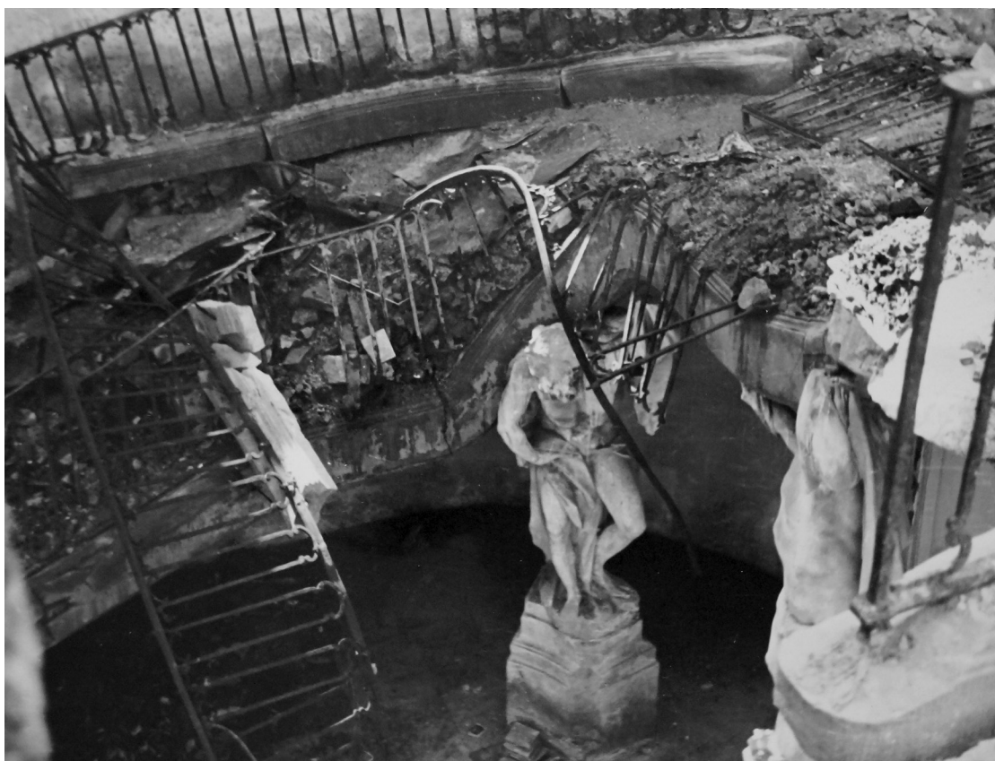
Fotografia 54. Obraz zniszczeń wewnątrz pałacowych. Autor zdjęcia: Władysław Paszkowski. Data wykonania: 1946. Oryginał w: WUOZwB
