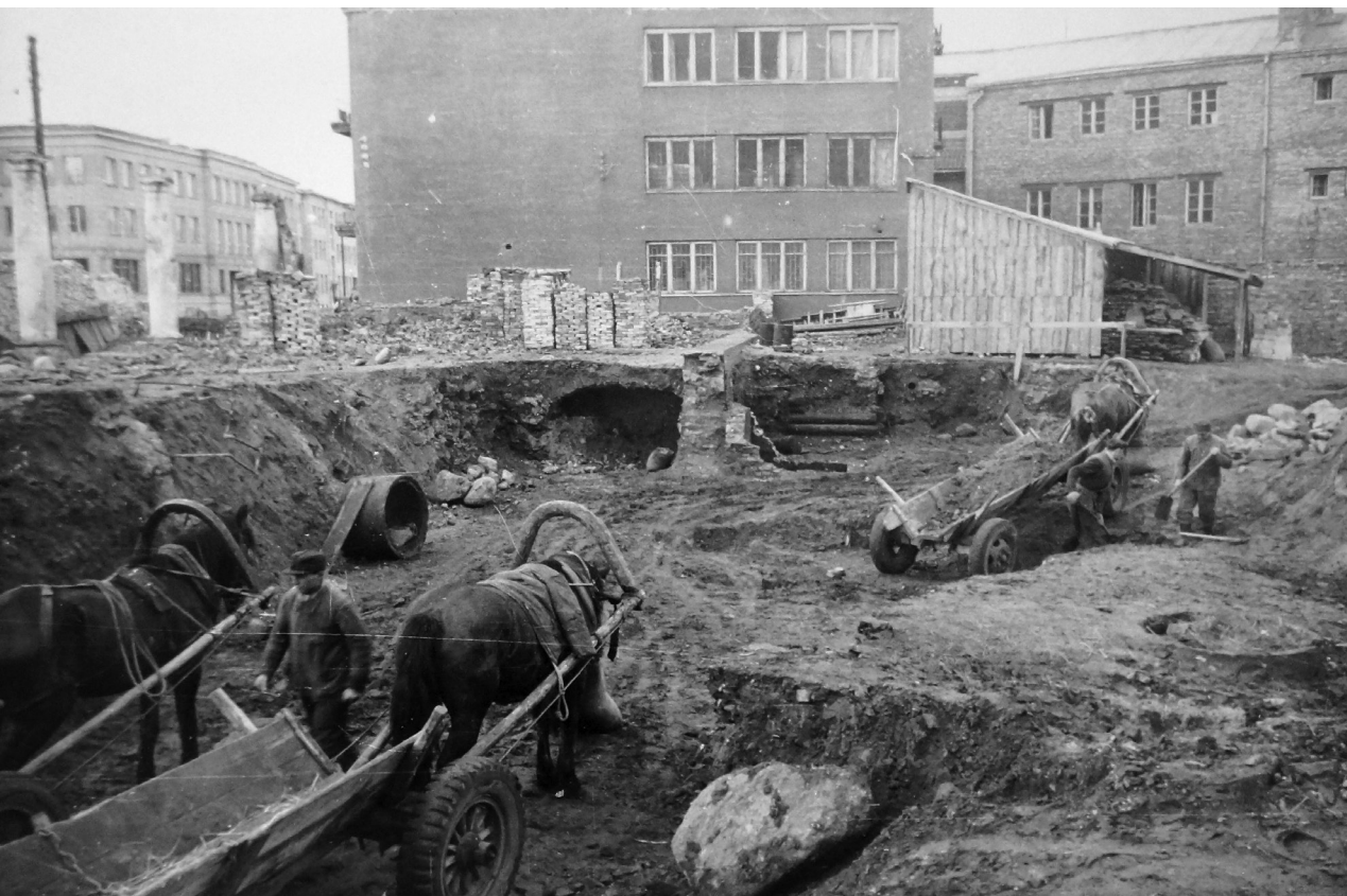
Fotografia 129. Prace przygotowawcze do odbudowy zbrojowni Branickich przy Rynku Kościuszki. Autor zdjęcia: Władysław Paszkowski.
