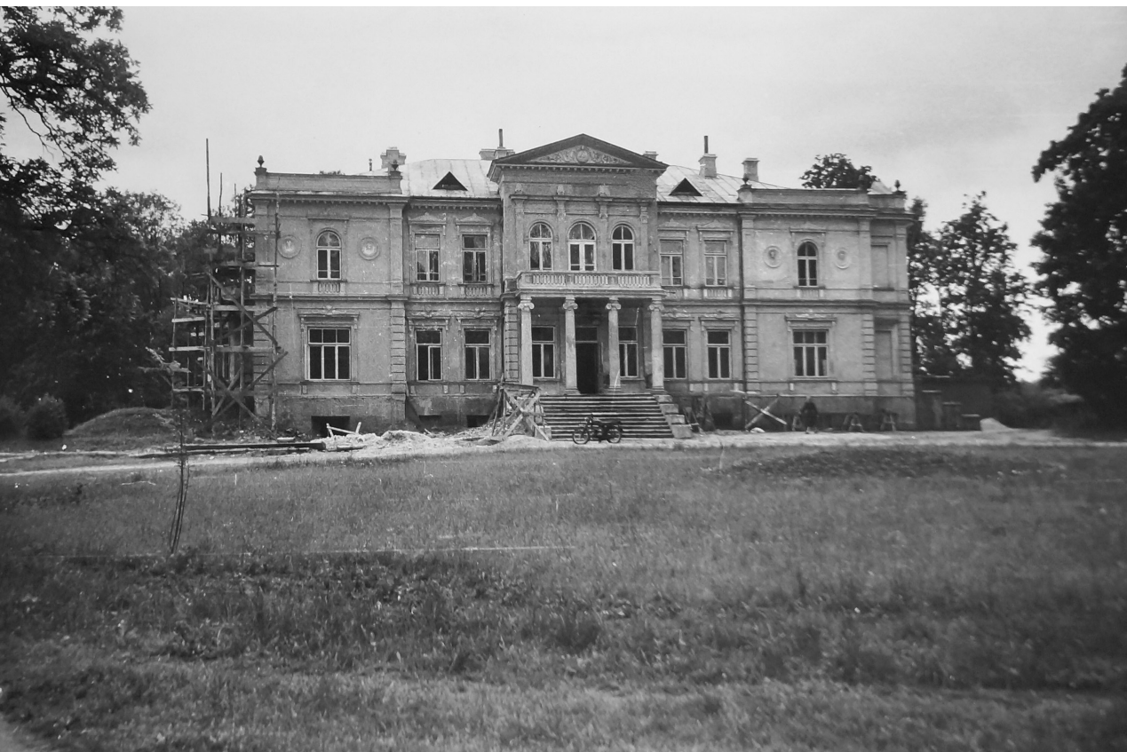
Fotografia 169. Odbudowa pałacu Lubomirskich – widok z dalszej perspektywy na fasadę frontową (północną). Autor zdjęcia: Władysław Paszkowski. Data wykonania: 1956.
