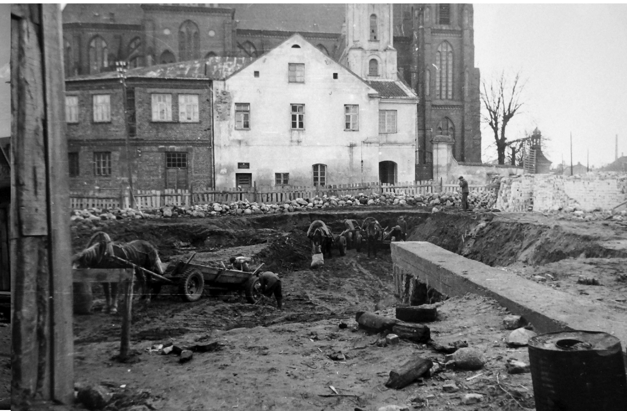
Fotografia 128. Prace przygotowawcze do odbudowy zbrojowni Branickich przy Rynku Kościuszki. Autor zdjęcia: Władysław Paszkowski.
