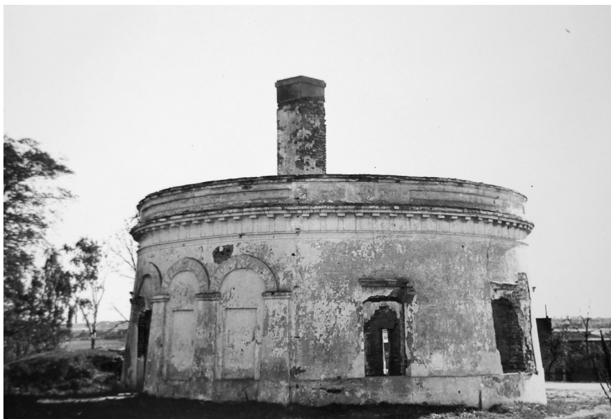
Fotografia 161. Obraz zniszczeń komory celnej. Autor zdjęcia: Władysław Paszkowski. Data wykonania: 1948. Oryginał w: WUOZwB
