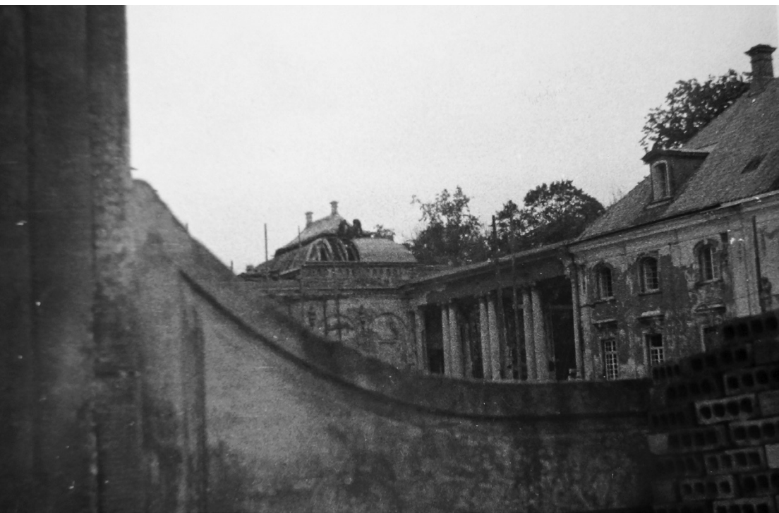
Fotografia 75. Widok zza muru oddzielającego dziedzińce wstępny i honorowy na zrekonstruowaną kolumnową galerię łączącą pałac z odbudowywaną prawą (północną) oficyną boczną. Autor zdjęcia: Władysław Paszkowski. Data wykonania: 1949. Oryginał w: WUOZwB
