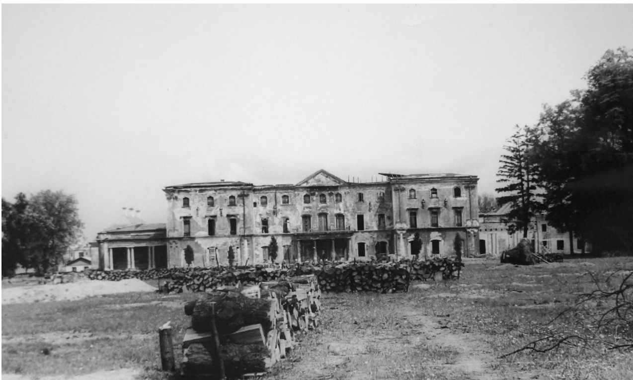
Fotografia 38. Widok na fasadę pałacu od strony ogrodowej po wycince drzewostanu.
