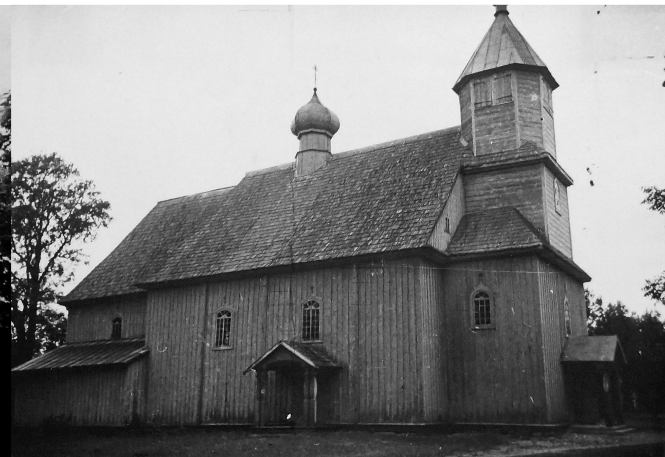
Fotografia 236. Widok na elewację wschodnią prostopadłościennego korpusu nawowego nakrytego dwuspadowym dachem i zwieńczonego kopułką. Autor zdjęcia: Władysław Paszkowski. Data wykonania: 1952. Oryginał w: WUOZwB
