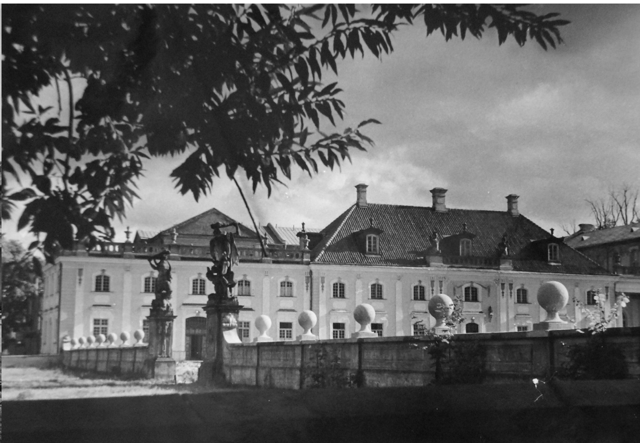
Fotografia 94. Widok zza zrekonstruowanego muru oddzielającego dziedzińce wstępny i honorowy na odbudowaną lewą (południową) oficynę boczną. Autor zdjęcia: Władysław Paszkowski. Data wykonania: 1961. Oryginał w: WUOZwB
