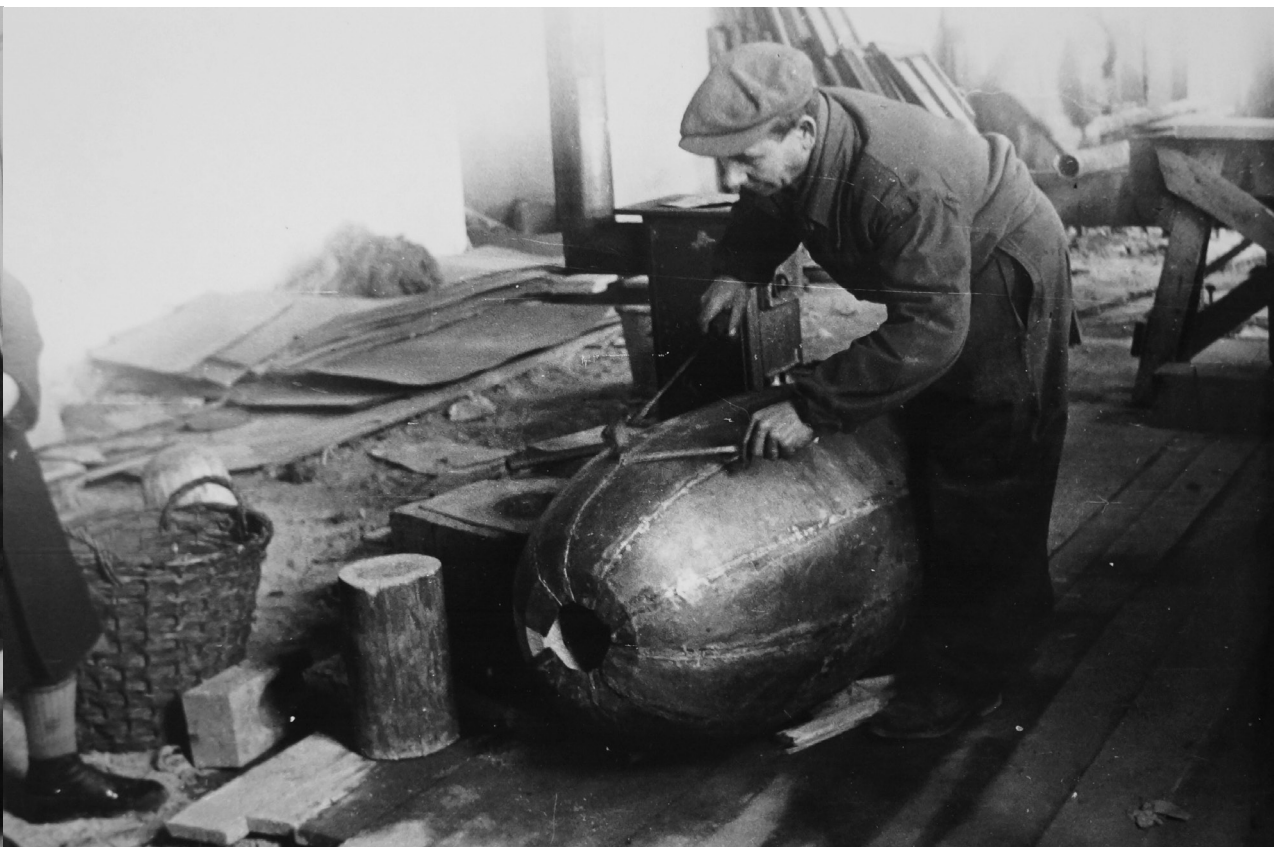
Fotografia 88. Spoinowanie zwieńczeń hełmów wież pałacowych. Autor zdjęcia: Władysław Paszkowski. Data wykonania: 1952. Oryginał w: WUOZwB
