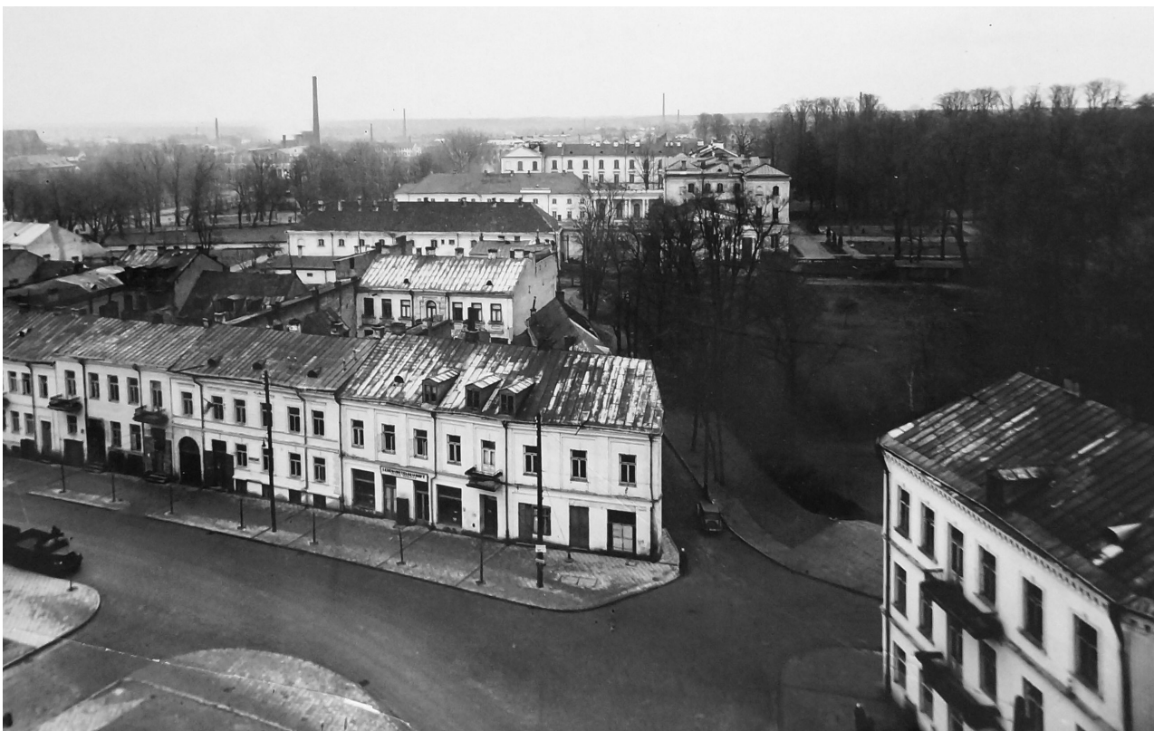
Fotografia 20. Widok z wieży katedralnej na pobliski kompleks pałacowy i położoną pomiędzy nimi zabudowę. Autor zdjęcia: NN. Data wykonania: 1939. Kopia w: WUOZwB
