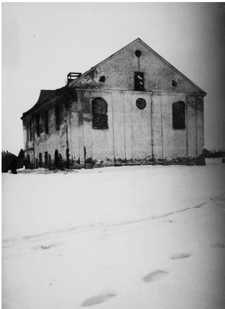
Fotografia 215. Widok na fasadę wschodnią synagogi. Autor zdjęcia: Władysław Paszkowski. Data wykonania: 1950. Oryginał w: WUOZwB
