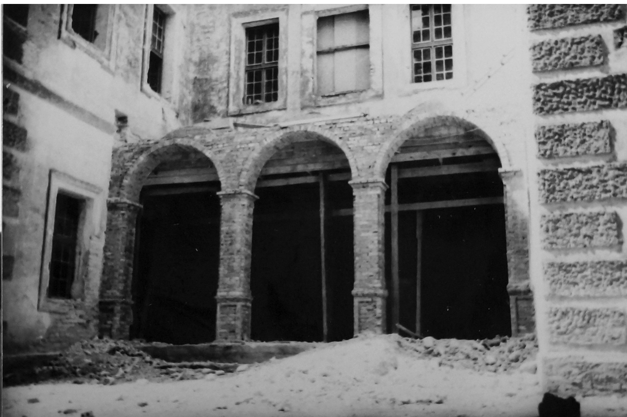
Fotografia 194. Obraz zniszczeń obiektów klasztornych. Autor zdjęcia: Władysław Paszkowski. Data wykonania: 1956. Oryginał w: WUOZwB
