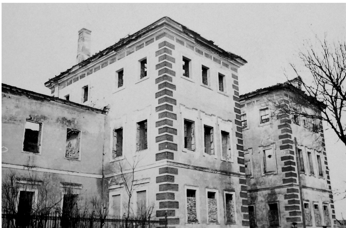
Fotografia 196. Obraz zniszczeń obiektów klasztornych. Autor zdjęcia: Władysław Paszkowski. Data wykonania: 1946. Oryginał w: WUOZwB
