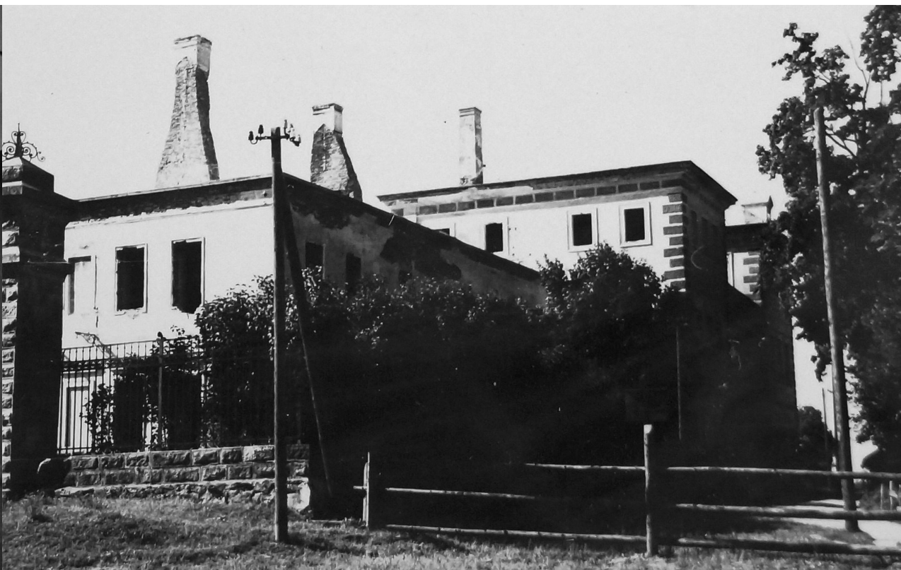
Fotografia 192. Obraz zniszczeń obiektów klasztornych. Autor zdjęcia: Władysław Paszkowski. Data wykonania: 1949. Oryginał w: WUOZwB
