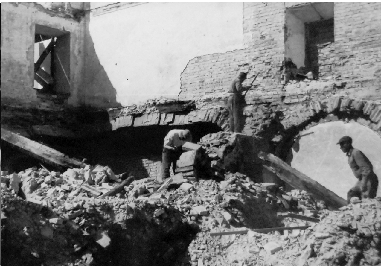
Fotografia 198. Prace przy odgruzowaniu ruin zabudowań klasztornych. Autor zdjęcia: Władysław Paszkowski. Data wykonania: 1949. Oryginał w: WUOZwB
