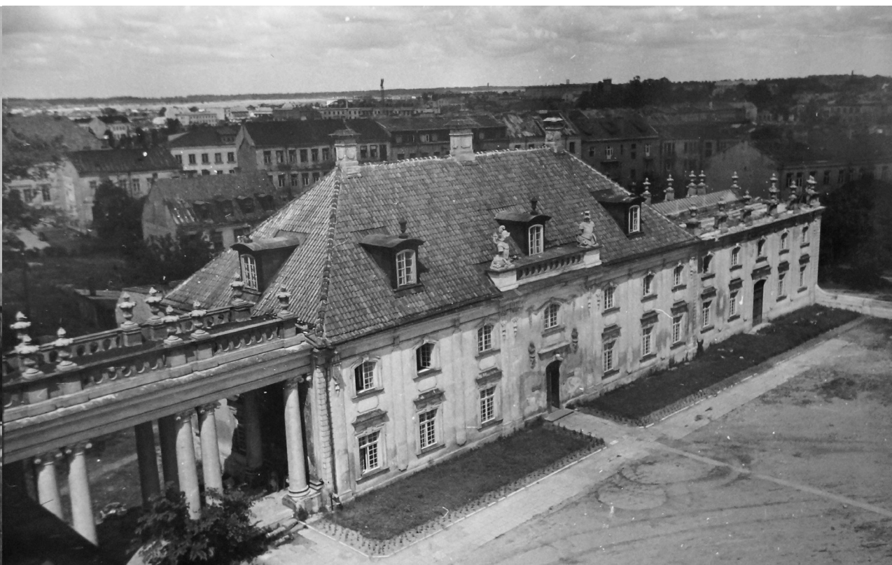
Fotografia 92. Widok z dachu korpusu głównego na zrekonstruowaną kolumnową galerię łączącą pałac z odbudowaną prawą (północną) oficyną boczną. Autor zdjęcia: Władysław Paszkowski. Data wykonania: 1955. Oryginał w: WUOZwB
