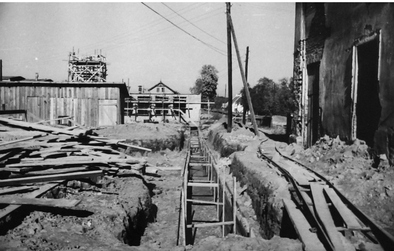
Fotografia 199. Odbudowa zabudowań klasztornych. Autor zdjęcia: Władysław Paszkowski. Data wykonania: 1947. Oryginał w: WUOZwB
