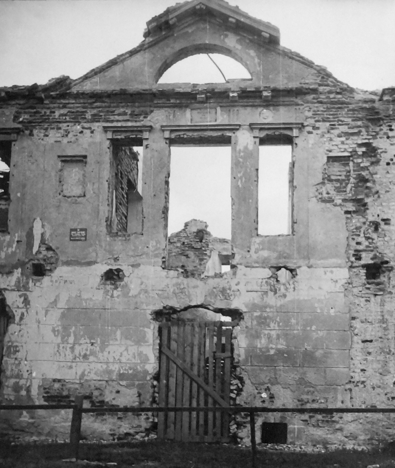
Fotografia 272. Widok w zniszczonej fasadzie frontowej na otwory po drzwiach wejściowych oraz dwóch dużych oknach i porte-fenêtre na osi środkowej, powyżej których pozostałości trójkątnego frontonu obwiedzionego gzymsem z półkolistym oknem w polu. Autor zdjęcia: Władysław Paszkowski. Data wykonania: 1947. Oryginał w: WUOZwB
