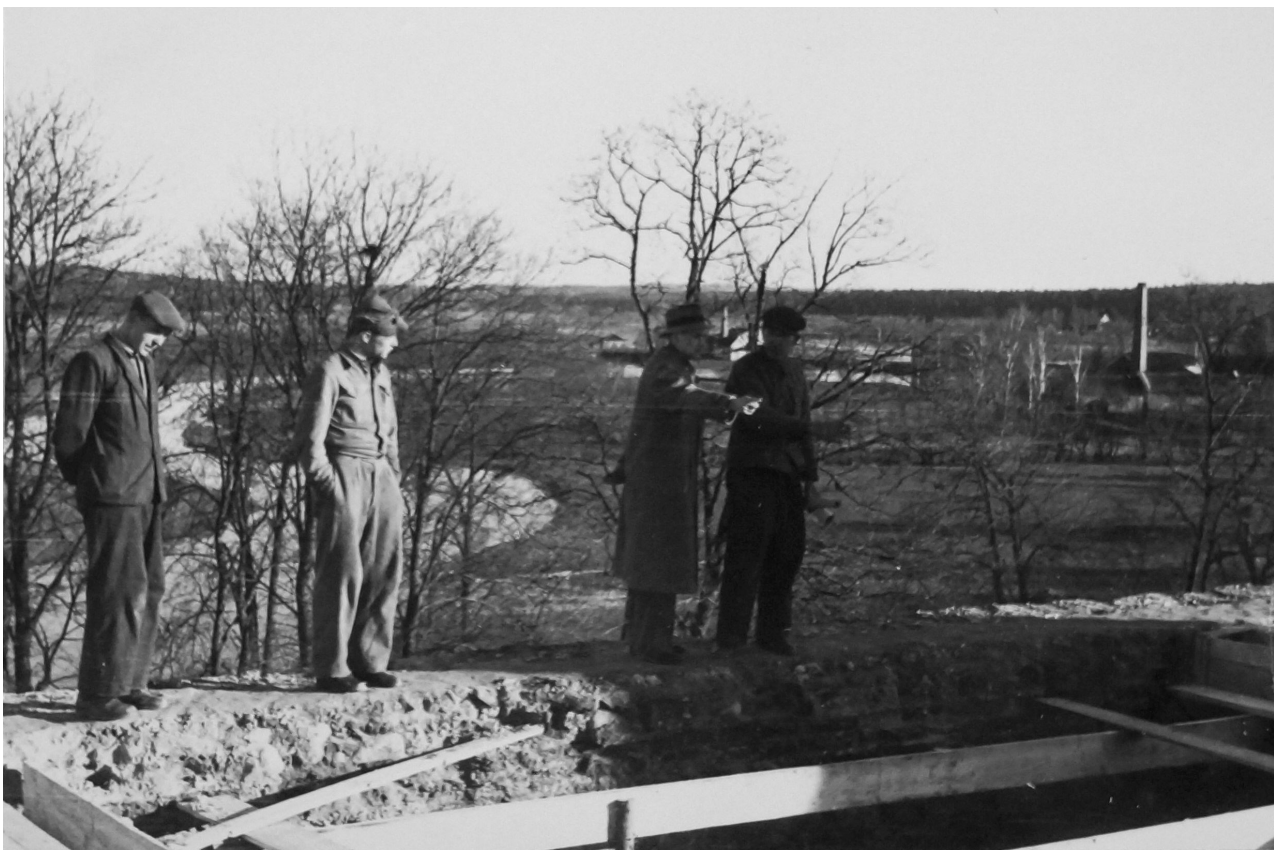
Fotografia 3. Supraśl 1947. Przy odbudowie pałacu Opatów
