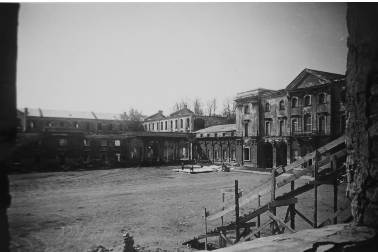
Fotografia 67. Widok na dziedziniec honorowy i lewą (południową) oficynę boczną pałacu.
