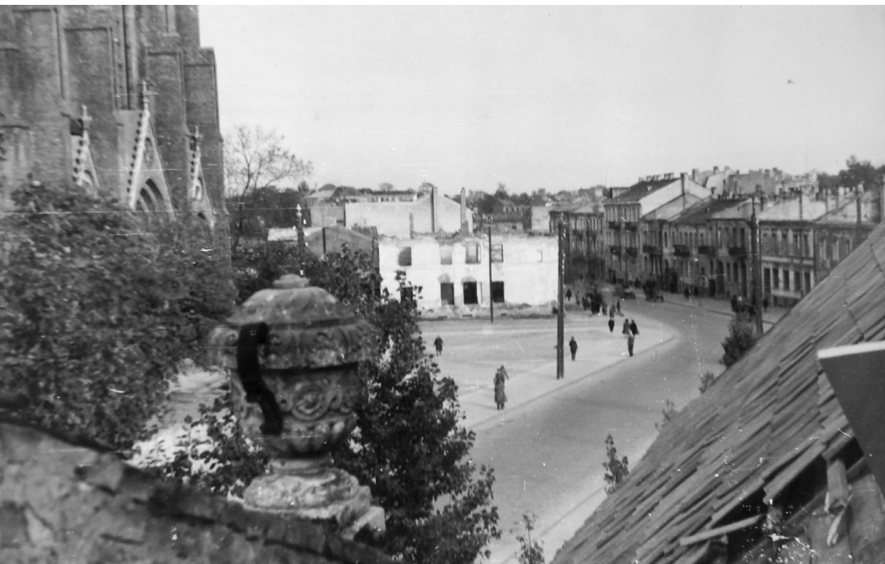
Fotografia 133. Widok z dachu klasztoru Zgromadzenia Sióstr Miłosierdzia (szarytek) na zabudowę u wlotu ul. Jana Kilińskiego. Autor zdjęcia: Władysław Paszkowski. Data wykonania: 1946. Oryginał w: WUOZwB
