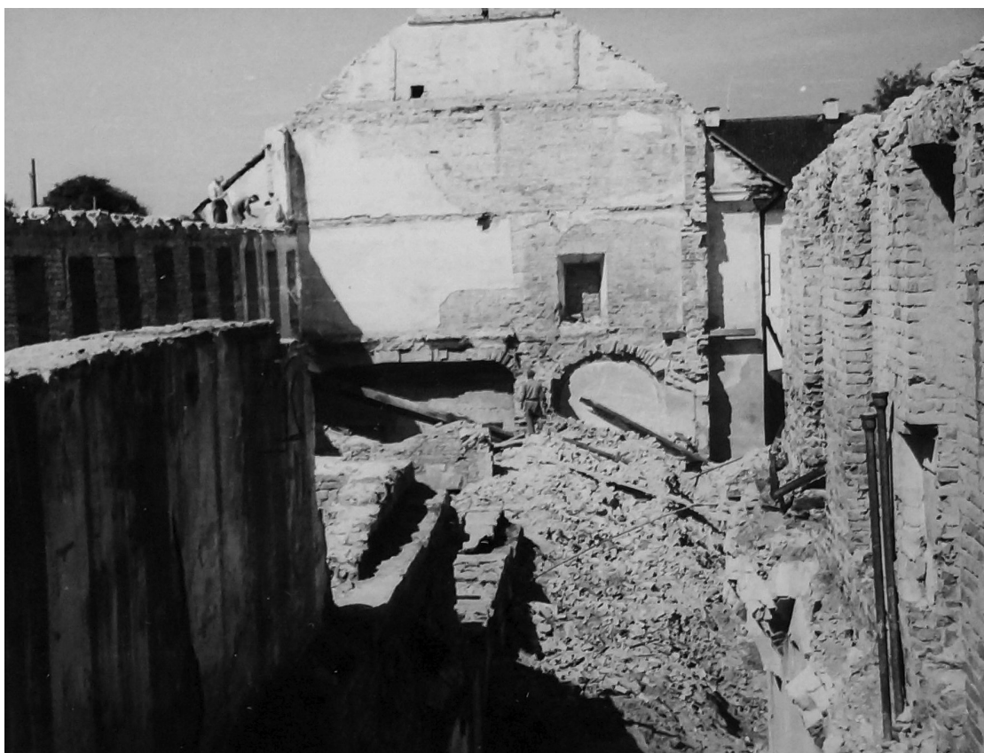
Fotografia 186. Obraz zniszczeń obiektów klasztornych. Autor zdjęcia: Władysław Paszkowski. Data wykonania: 1949. Oryginał w: WUOZwB
