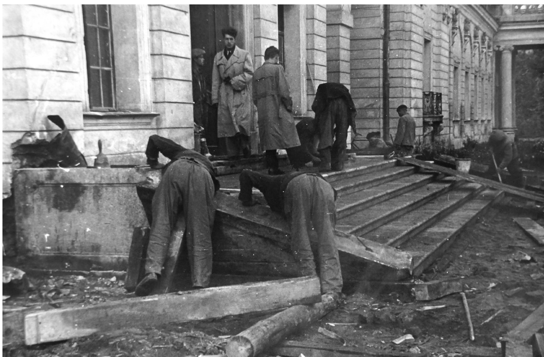
Fotografia 82. Kontrola nadzoru konserwatorskiego nad rekonstrukcją schodów wejściowych od strony dziedzińca honorowego. Autor zdjęcia: Władysław Paszkowski. Data wykonania: 1955. Oryginał w: WUOZwB
