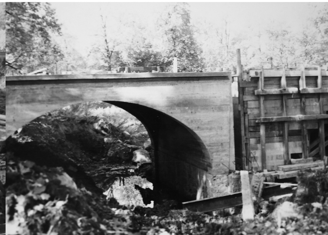
Fotografia 110. Odbudowane przęsło pałacowego mostu ogrodowego. Autor zdjęcia: Władysław Paszkowski. Data wykonania: 1967. Oryginał w: WUOZwB
