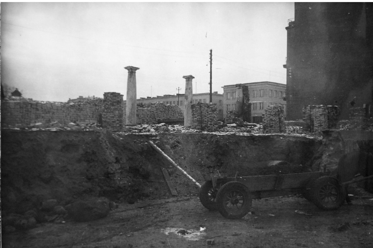
Fotografia 130. Prace przygotowawcze do odbudowy zbrojowni Branickich przy Rynku Kościuszki. Autor zdjęcia: Władysław Paszkowski. Data wykonania: 1953. Oryginał w: WUOZwB
