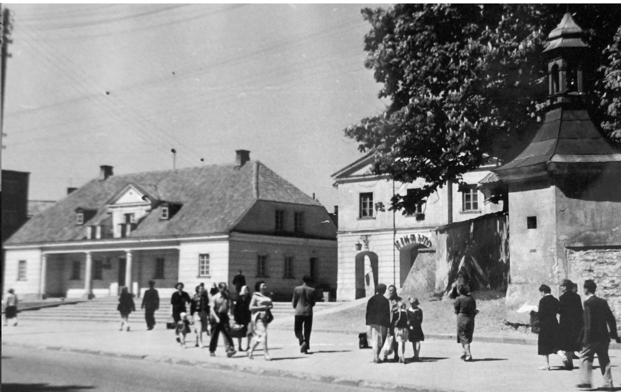
Fotografia 154. Zrekonstruowana zbrojownia Branickich przy Rynku Kościuszki. Autor zdjęcia: Władysław Paszkowski. Data wykonania: 1957. Oryginał w: WUOZwB
