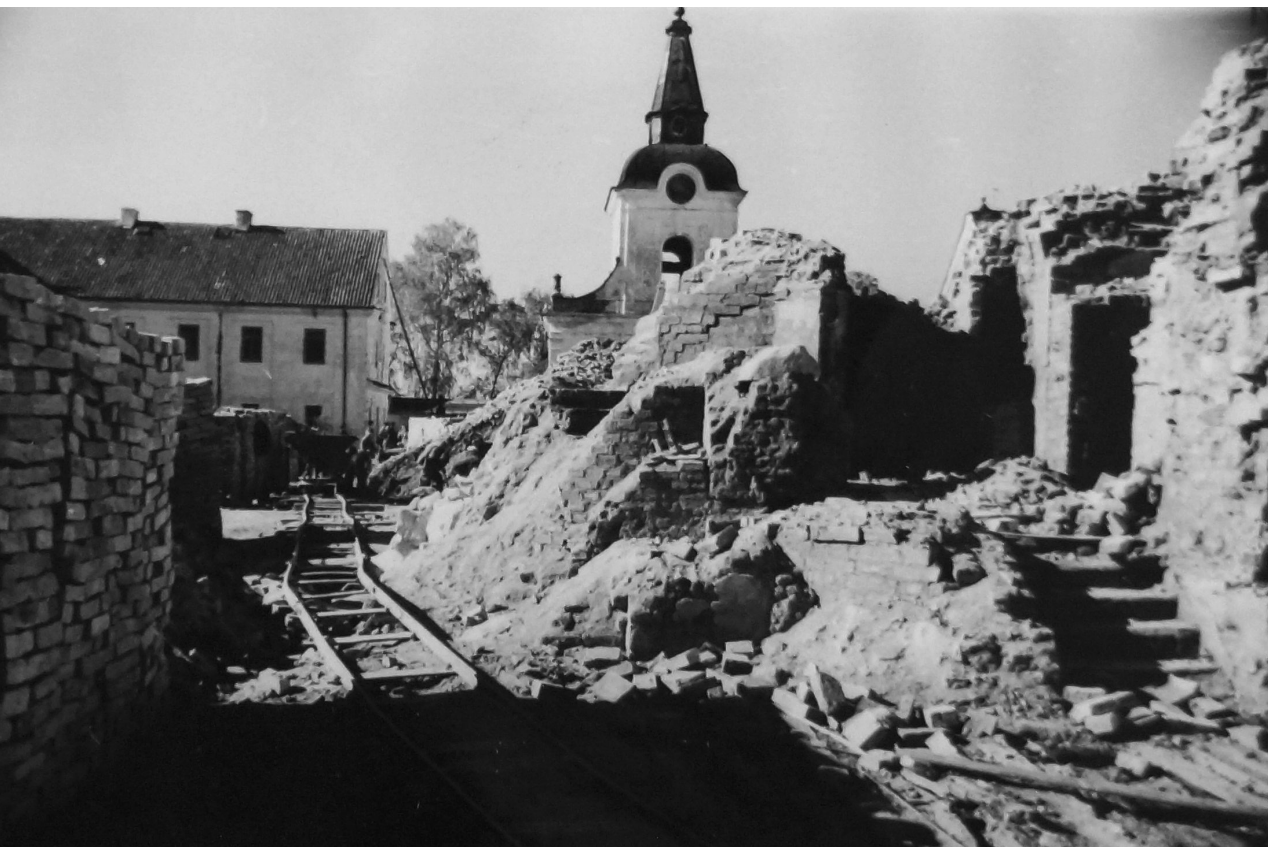
Fotografia 185. Prace przy odgruzowaniu ruin cerkwi Zwiastowania NMP. Autor zdjęcia: Władysław Paszkowski. Data wykonania: 1947. Oryginał w: WUOZwB
