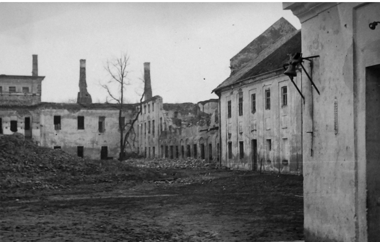
Fotografia 191. Obraz zniszczeń obiektów klasztornych. Autor zdjęcia: Władysław Paszkowski. Data wykonania: 1947. Oryginał w: WUOZwB
