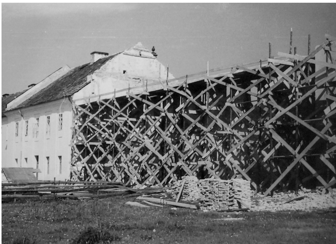
Fotografia 200. Odbudowa zabudowań klasztornych. Autor zdjęcia: Władysław Paszkowski. Data wykonania: 1949. Oryginał w: WUOZwB
