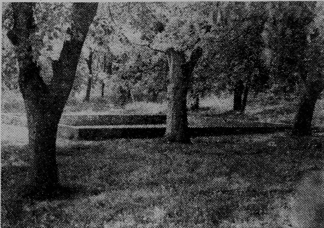
Ten urokliwy zakątek to fragment dawnego ogródka jordanowskiego nad Narwią. Jak cała skarpa, obrócił się w ruinę. Podobno ma tu być budowany ośrodek rekreacyjny. A nie prościej byłoby przywrócić dawną funkcję temu uroczemu miejscu?
