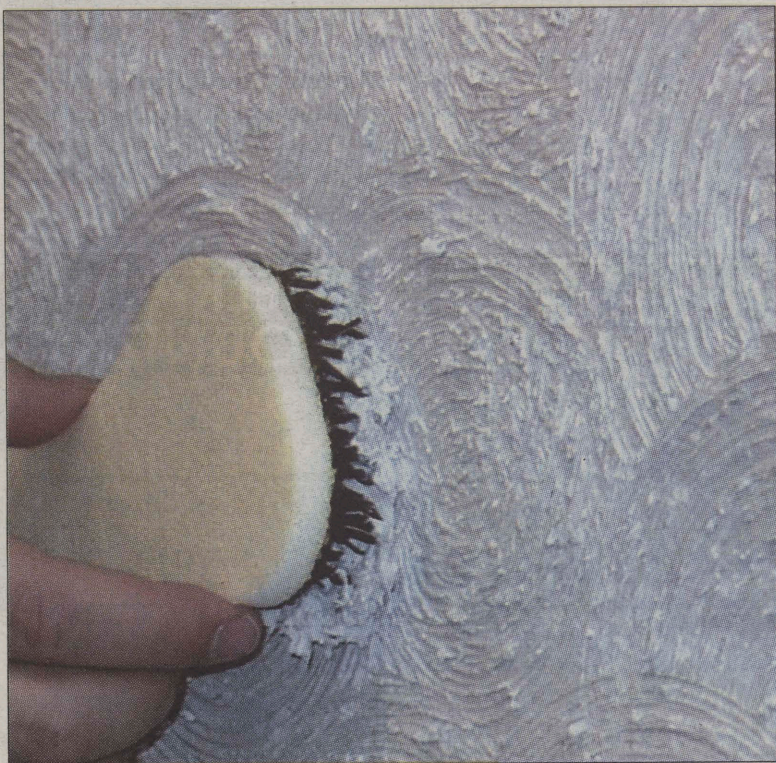
Po rozrobieniu suchej mieszanki tynku z odpowiednią ilością wody, masa przybiera gęstą konsystencję
