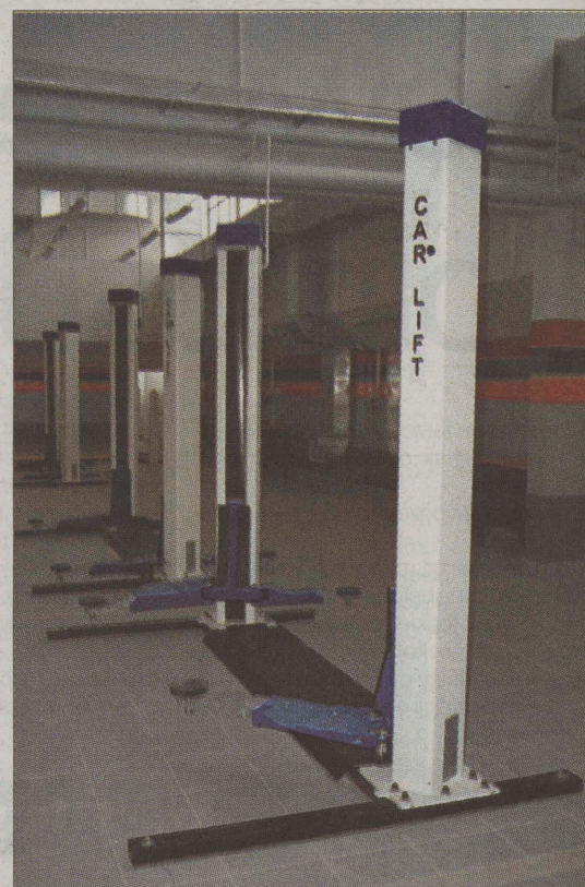
Hala obsługowo-naprawcza w nowym serwisie, tuż przed jego uruchomieniem
