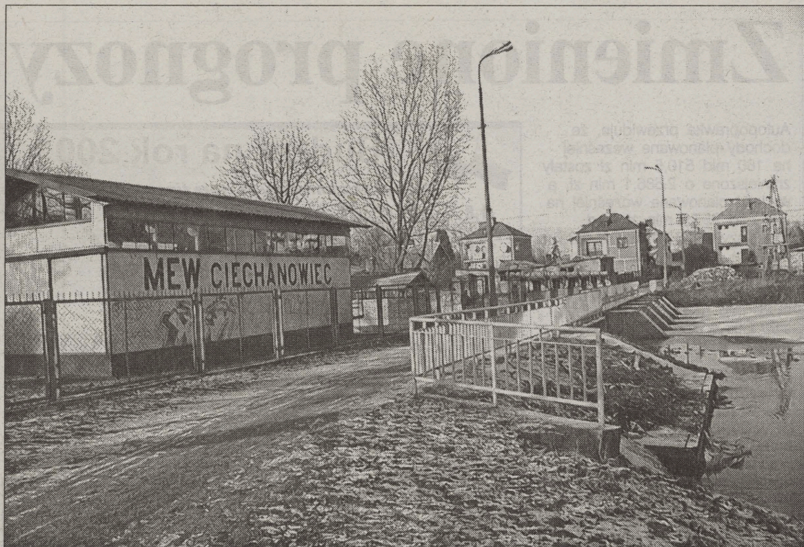
Mała elektrownia wodna na Nurcu w Ciechanowcu ma moc ok. 100 kW na godzinę, ale na skutek obniżenia się poziomu wody i osłabiających się spadku niesprawnych zasuw jazu, wykorzystuje się ją zaledwie w ok. 20 proc.
