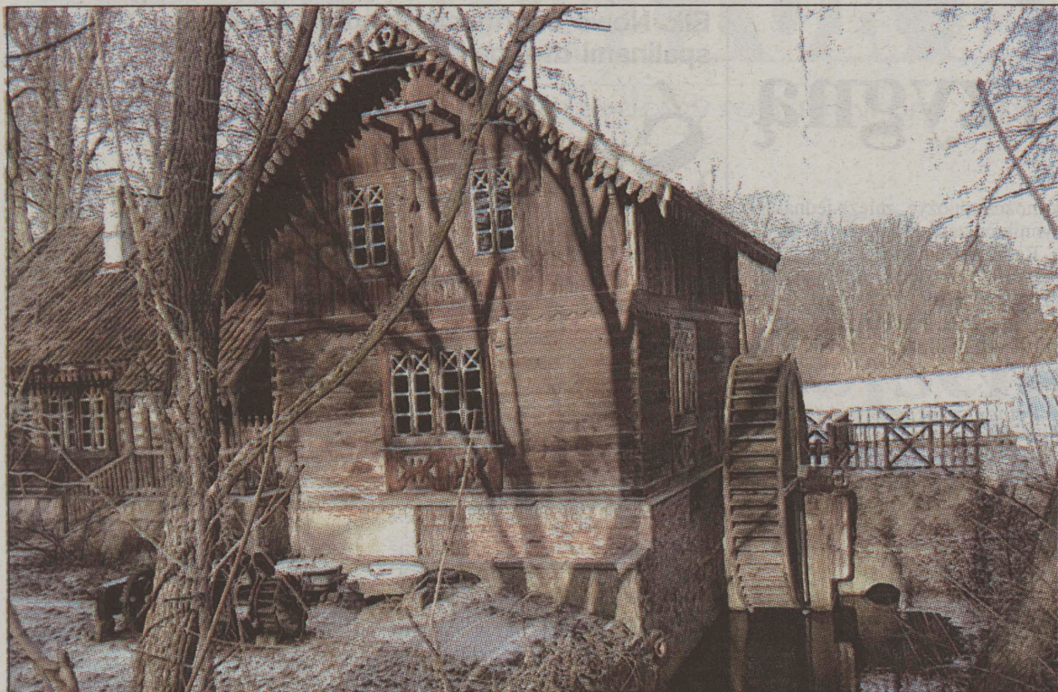
Po remoncie, na koło zabytkowego młyna skierowana zostanie woda
