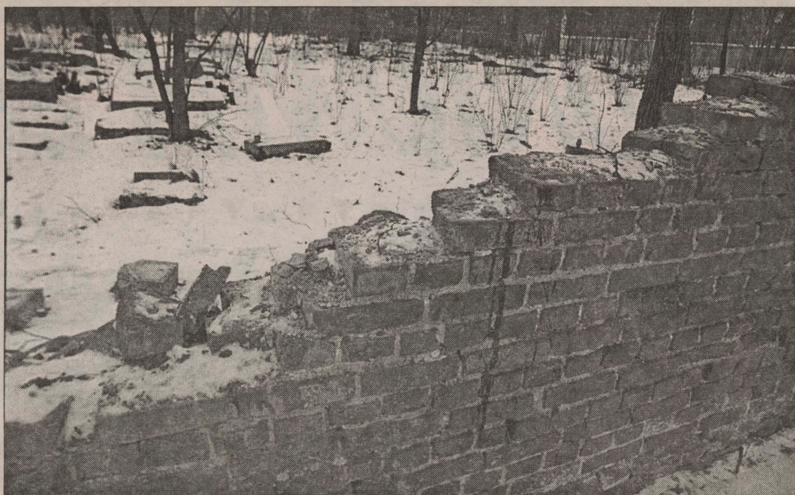
W tym roku Urząd Miejski jest w stanie zbudować tylko nowe ogrodzenie cmentarza
