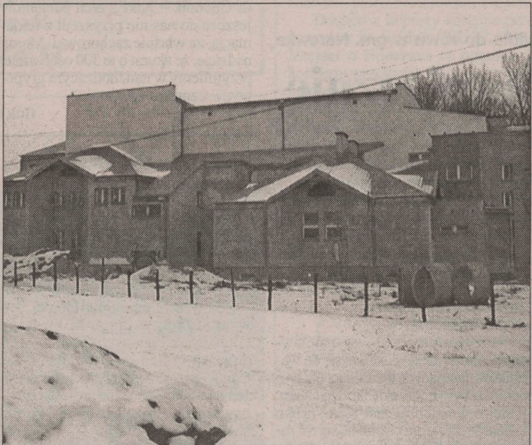
Nowy budynek DKL ma powierzchnię 2 tys. mkw. Niektórzy obawiają się, że radość z nowego domu mogą przyćmić duże koszty utrzymania budynku, związane choćby z ogrzewaniem.
