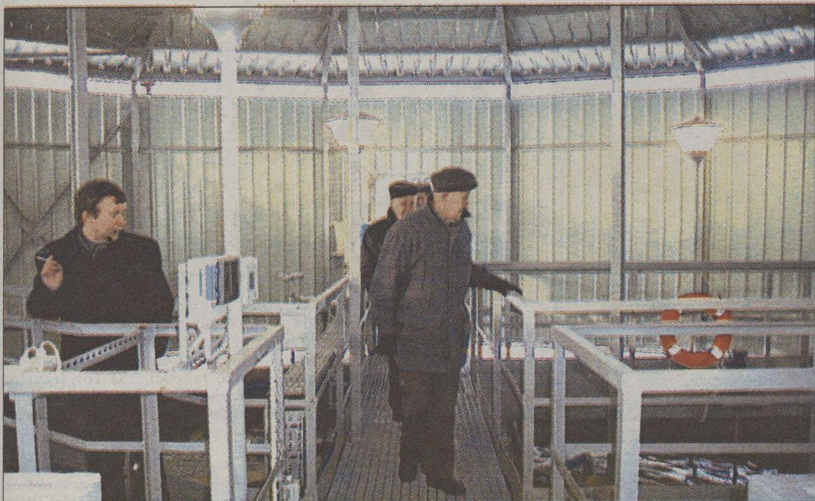
Nowa oczyszczalnia w Śniadowie ma przepustowość 200 msześć. na dobę
