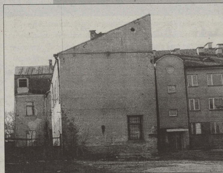
W przypadku tynków cienkowarstwowych, przed ich położeniem należy nanieść masę podkładową CERPLAST
