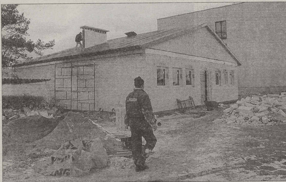
Ekipa budowlana kończy prace
