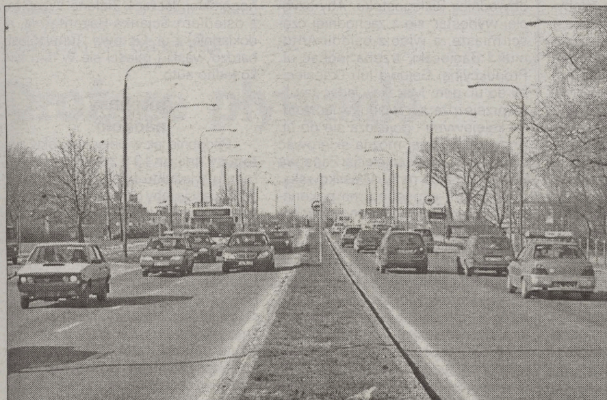
To już ostatnie dni jazdy po dwóch „nitkach” wiaduktu
