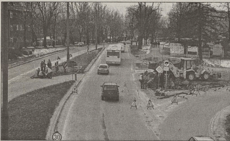
Wczoraj, w rejonie ul. Dąbrowskiego, trwały prace przy przebudowie dróg dojazdowych, prowadzących na wiadukt
