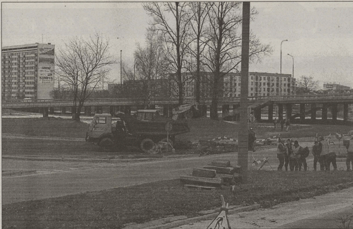
Na razie na wiadukcie wszystko zostaje bez zmian. Ekipy remontowe, co prawda, rozpoczęły przygotowania nowych wjazdów, ale wykonawca nie zdążył namalować pasów na jezdni. Prace rozpoczną się dopiero za tydzień.
