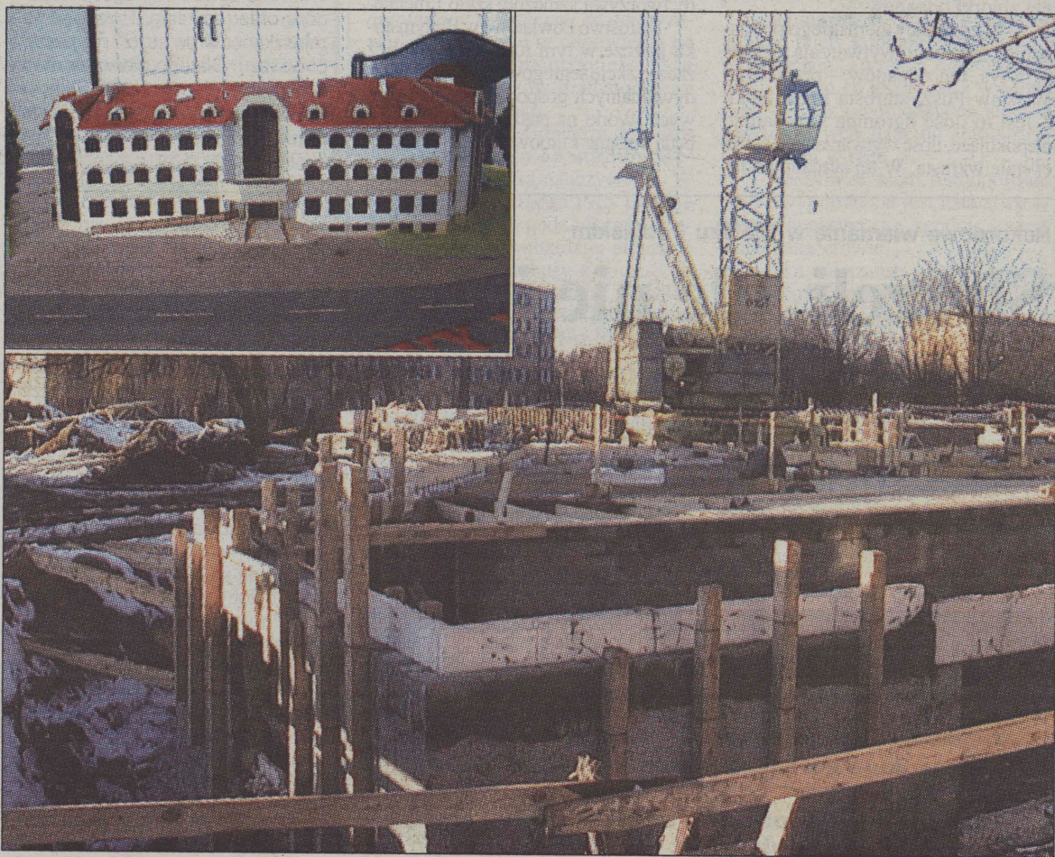
Przy ul. Polowej w Łomży rozpoczęła się budowa siedziby Sądu Rejonowego. Przed zimą wykonawca – Przasnyskie Przedsiębiorstwo Budowlane – wykonał fundamenty. Prace zostaną wznowione wiosną. Inwestycja zostanie zrealizowana w ciągu 3 lat kosztem 11 mln zł. W gmachu o powierzchni użytkowej 5 tys. mkw. znajdą lokum wszystkie wydziały łomżyńskiego sądu, rozrzucone obecnie po mieście. A tak będzie wyglądał gmach sądu (widok elewacji frontowej z głównym wejściem od ul. Polowej).
