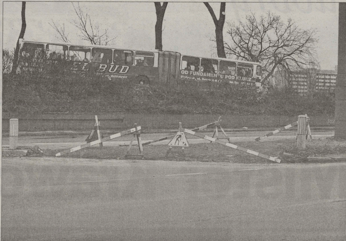
Nadal nie zakończono budowy przejazdów, które posłużą podczas remontu
