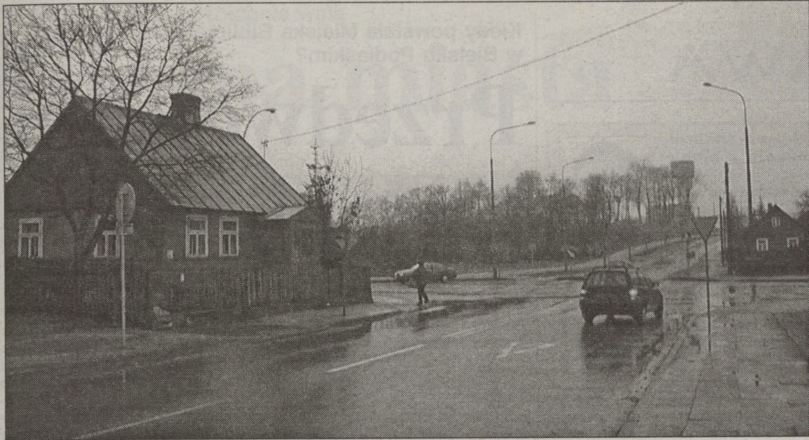
Aby mogło powstać rondo na skrzyżowaniu ulic Bulwarowej, Sikorskiego i E. Plater, musi zostać zburzony widoczny na zdjęciu budynek mieszkalny. W ubiegłym roku właścicielka posesji nie zgodziła się na proponowane jej przez miasto warunki wykupu działki.
