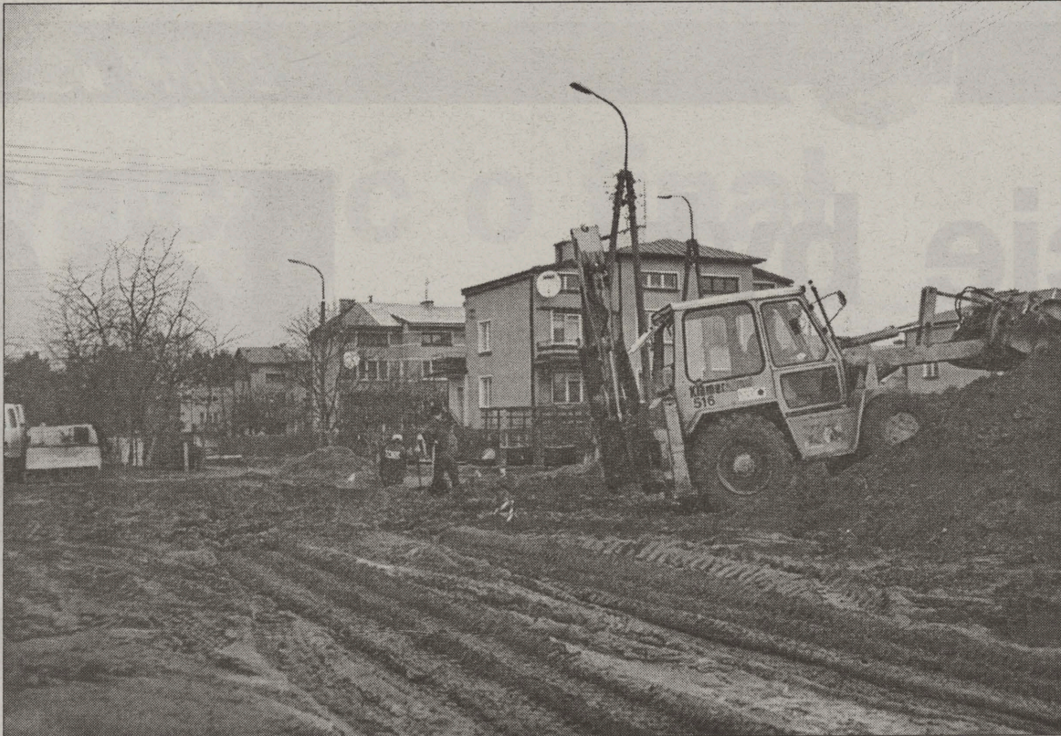
Obecnie trwają prace na ul. Bałtyckiej na osiedlu Starosielce
